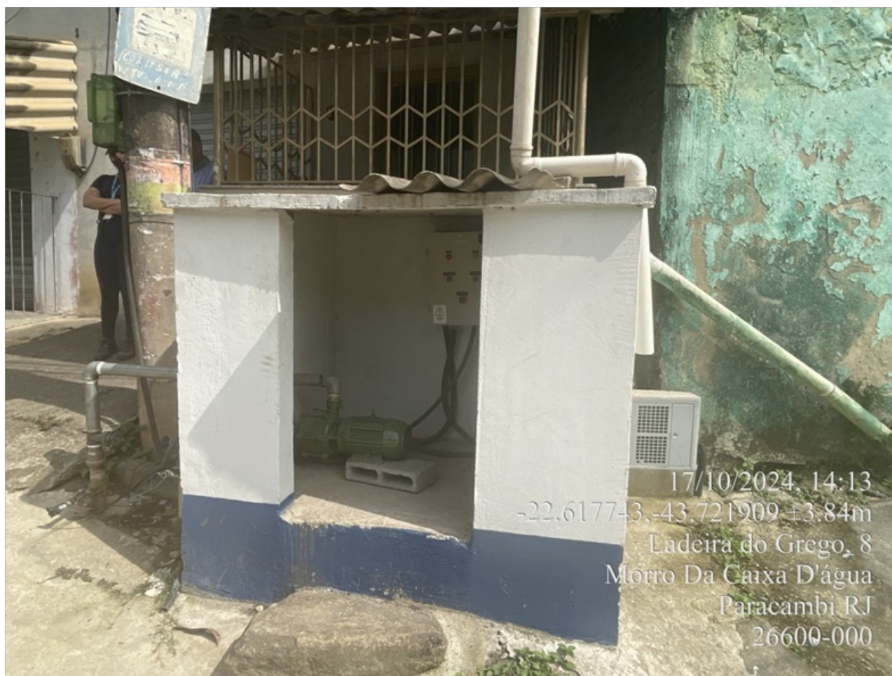
Foto 3 – Abrigo de alvenaria
