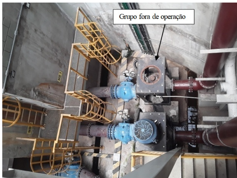
Foto 22 – Grupo fora de operação (sem motor)
