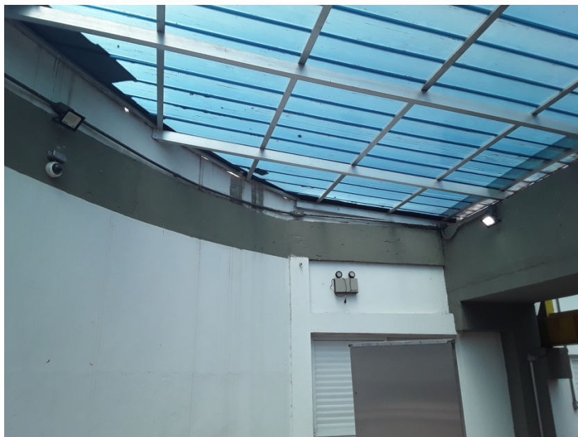
Foto 21 – Iluminação natural, artificial e de emergência
