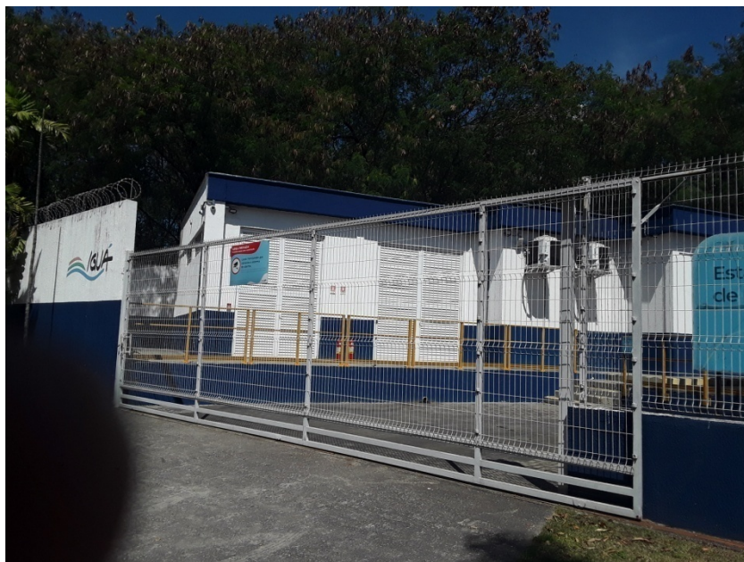
Foto 3 – Portão com acesso restrito e muro de alvenaria
