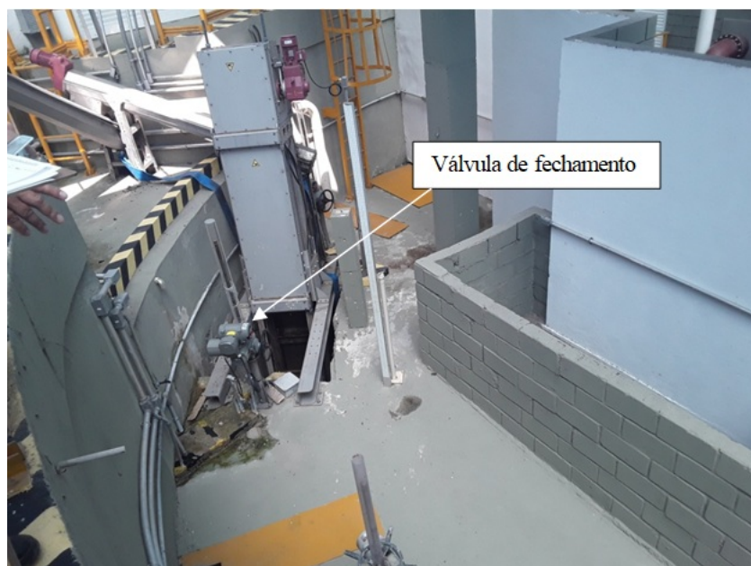
Foto 5 – Gradeamento mecânico do outro poço de sucção na chegada do esgoto
