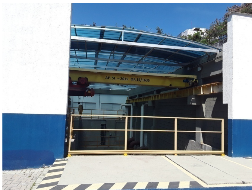
Foto 17 – Cobertura do poço das motobombas
