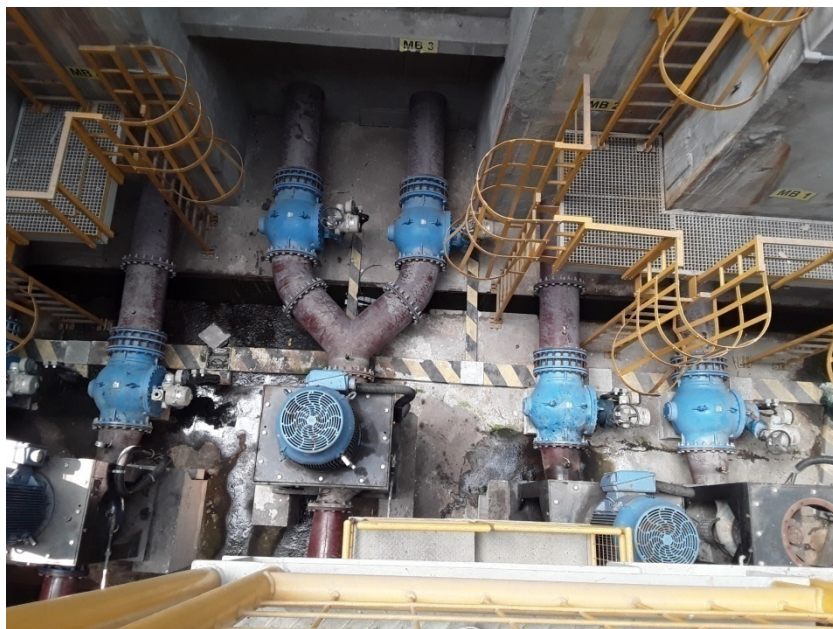
Foto 13 – Guarda corpos em escadas verticais
