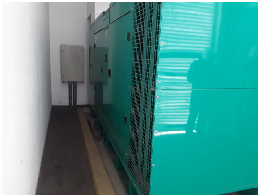
Foto 29 – Gerador com bacia de contenção
