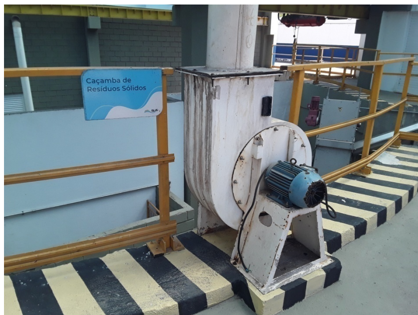
Foto 11 – Guarda corpo e sinalização de piso
