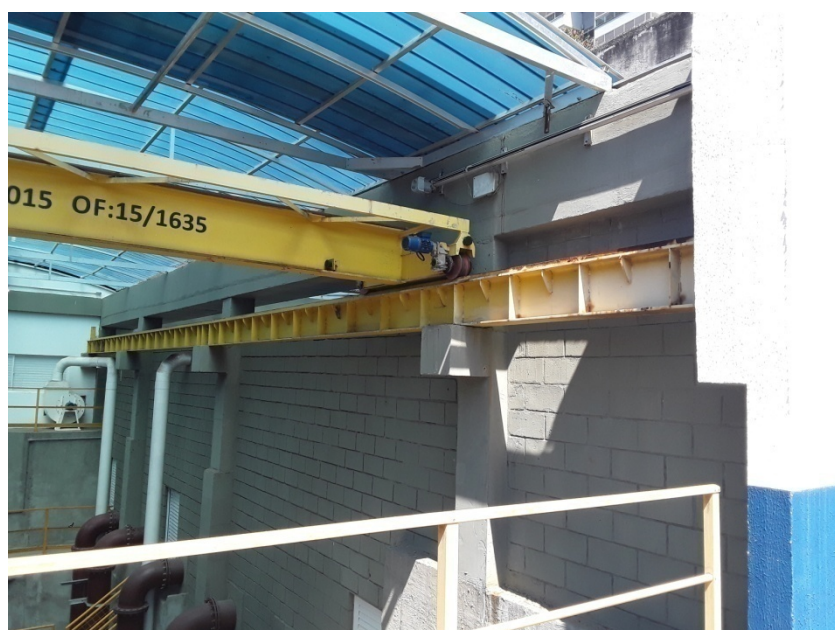
Foto 18 – Cobertura do poço das motobombas
