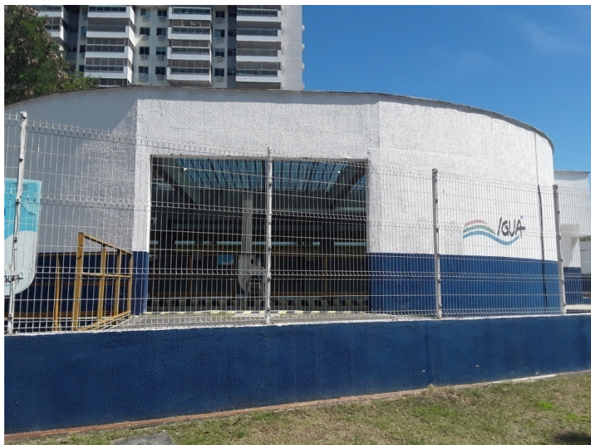
Foto 2 – Grades com base em muro de alvenaria
