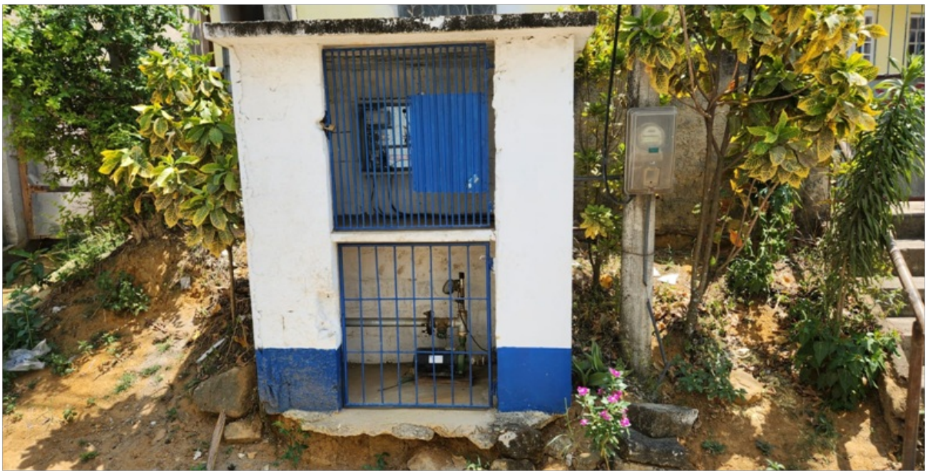
Foto 3 – Abrigo de alvenaria
