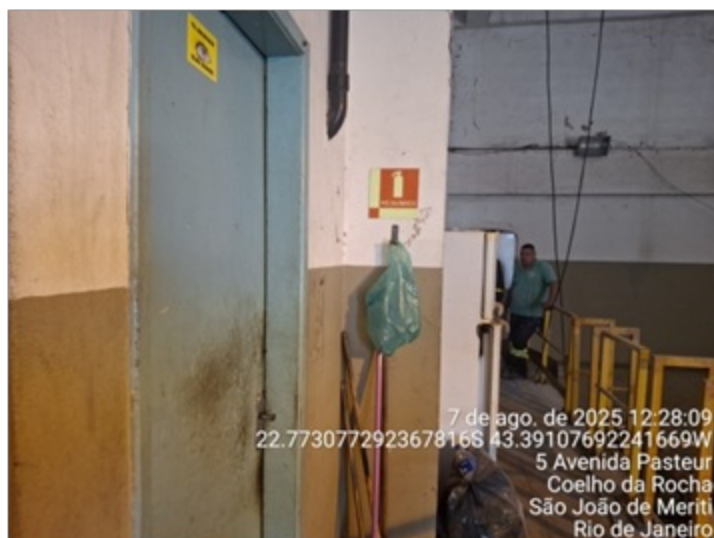
Foto 11 – Local destinado ao extintor
