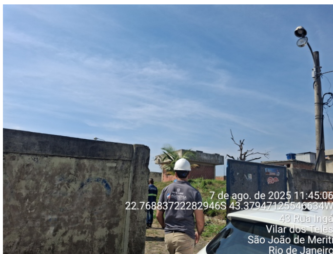
Foto 1: Portão de acesso a área do reservatório
