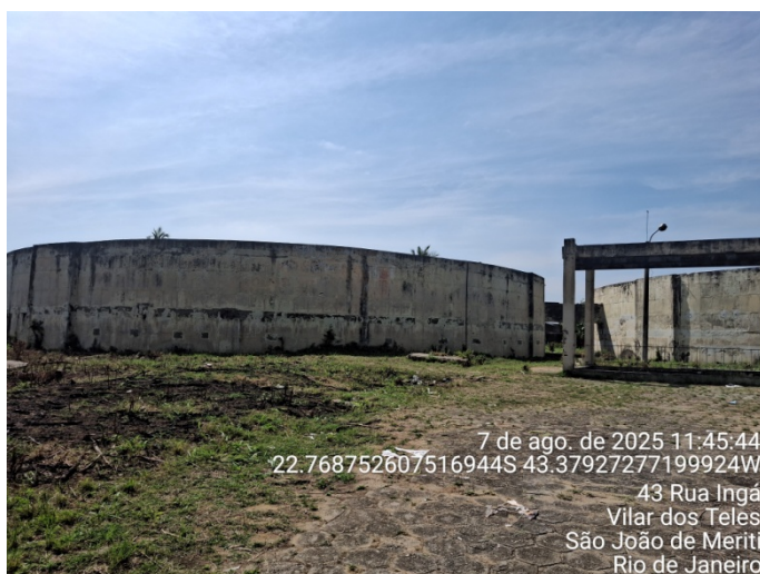
Foto 2: Reservatório vista externa
