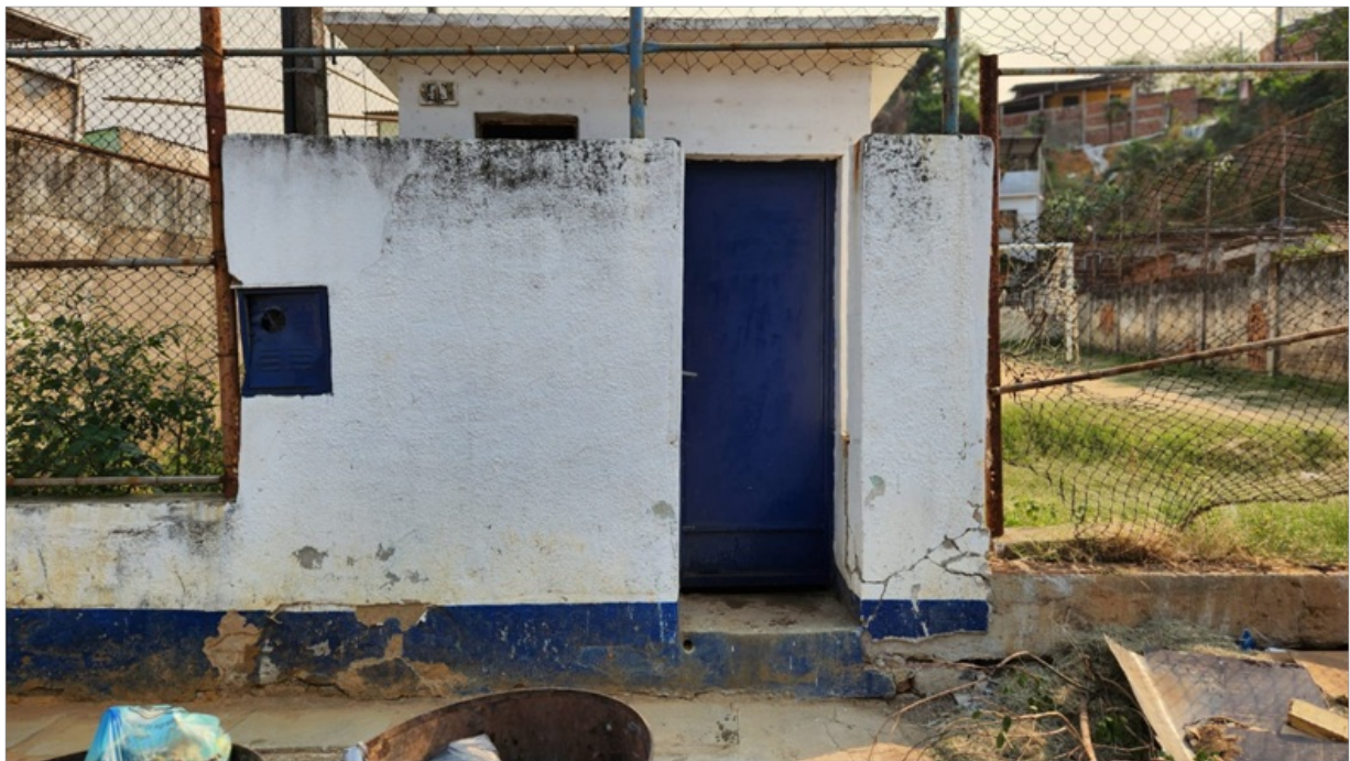
Foto 3 – Abrigo de alvenaria
