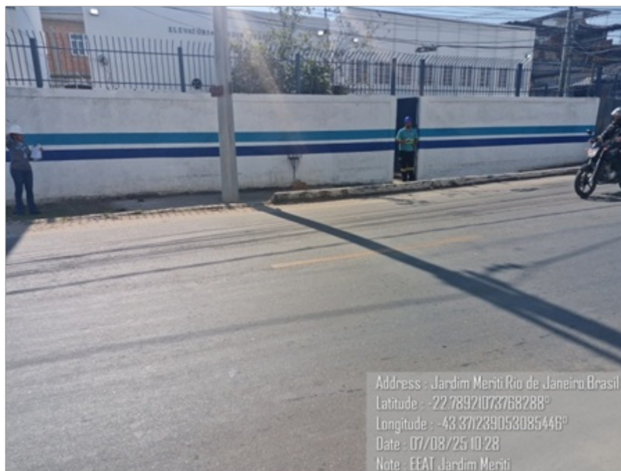
Foto 1 – Fachada abrigo do booster (ou elevatória)
