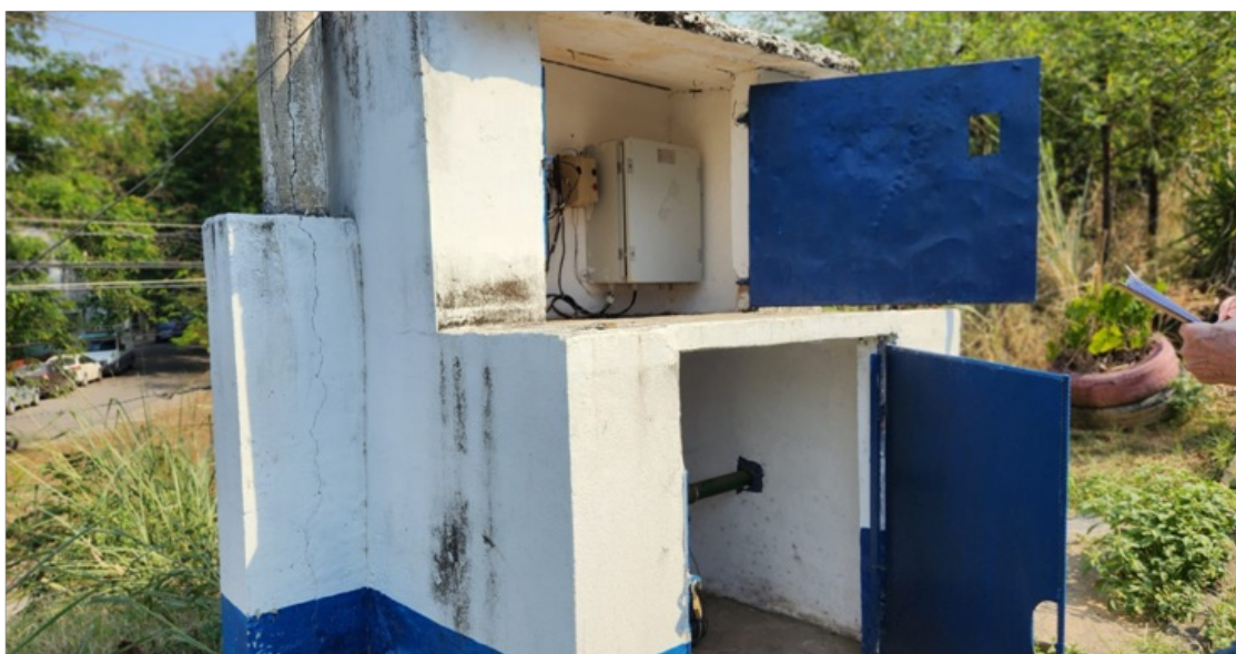
Foto 3 – Abrigo de alvenaria
