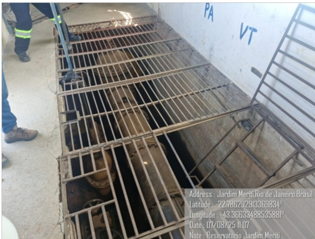
Foto 4: Barrilete do reservatório
