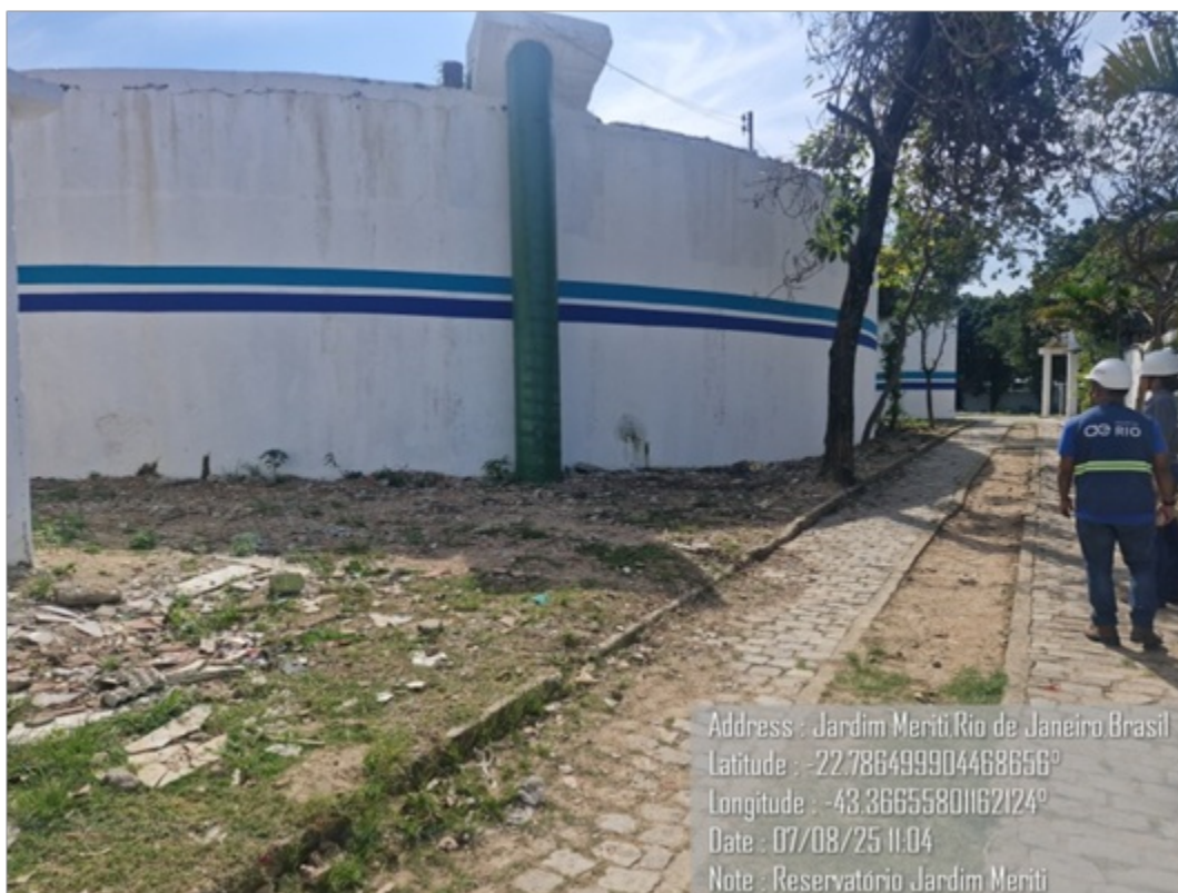
Foto 3: Reservatório vista externa – Tubulação de chegada
