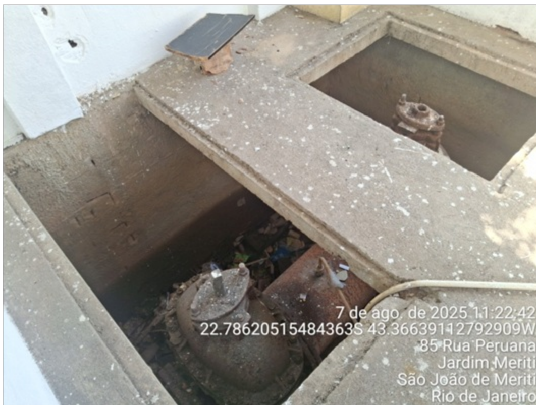
Foto 7: Tubulações extravassora e de limpeza
