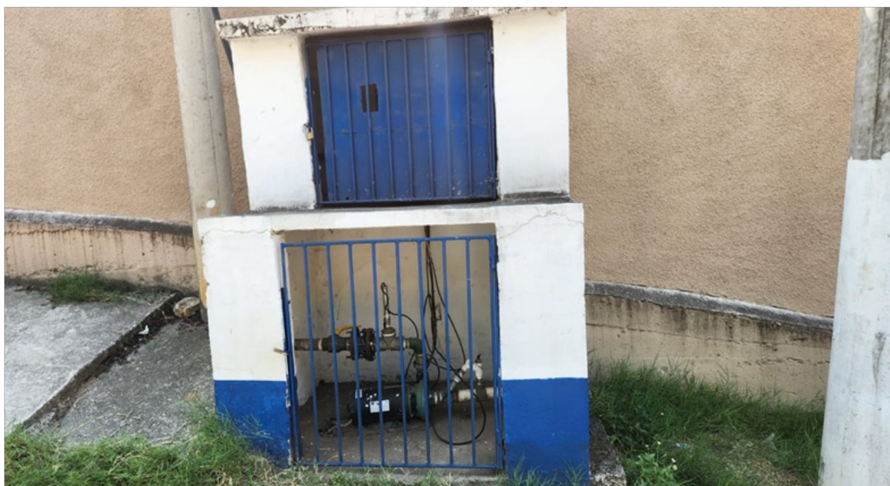
Foto 3 – Abrigo de alvenaria
