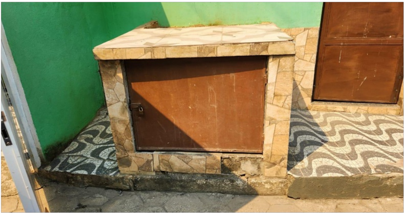
Foto 3 – Abrigo de alvenaria
