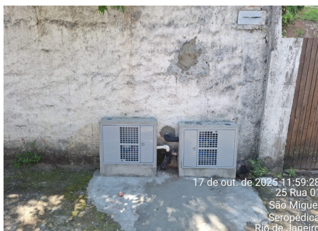
Fotos 6 e 7 – Finalização da instalação do hidrômetro com ponto para conexão interna
