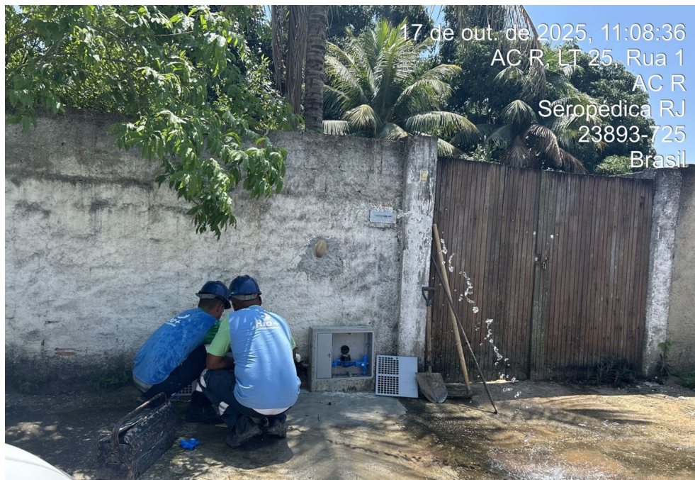
Foto 4 – Equipe operacional realizando a instalação do hidrômetro
