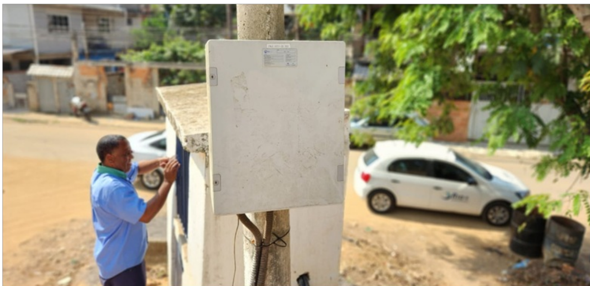
Foto 4 – Vista lateral do abrigo da elevatória
