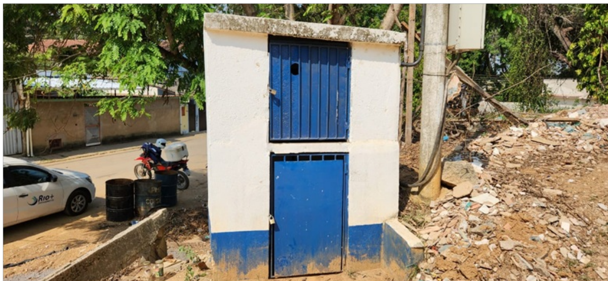
Foto 3 – Vista frontal do abrigo da elevatória
