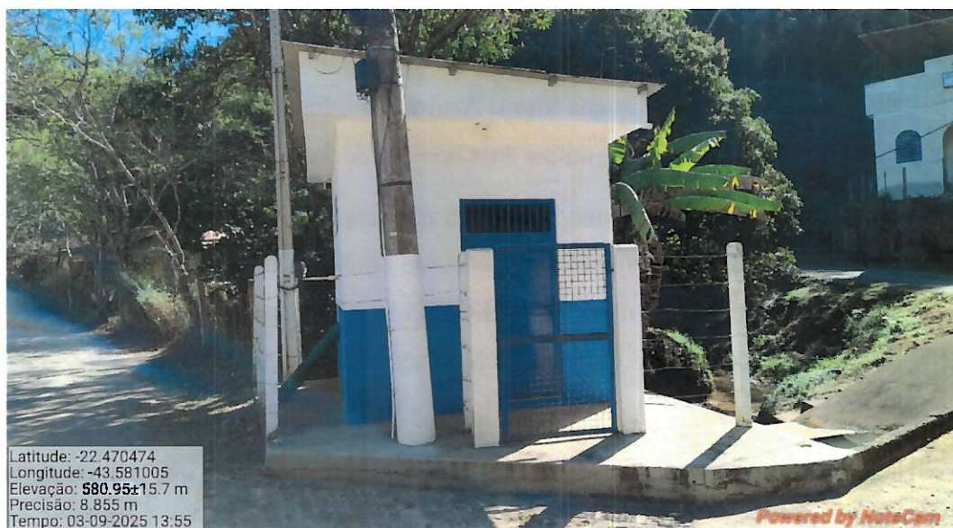
Foto 3: Abrigo da EEAB.
