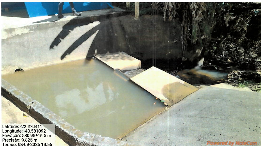
Foto 2: Ponto de captação (área sem proteção e sem placa de identificação de manancial com indicação de uso para consumo humano).
