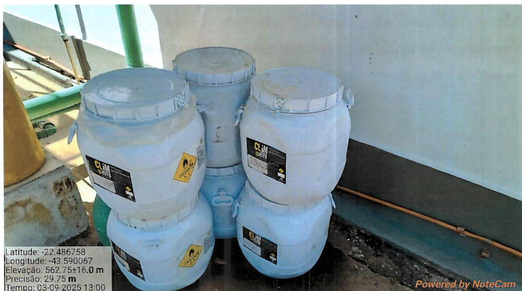
Foto 23: Armazenamento de hipoclorito de cálcio.
