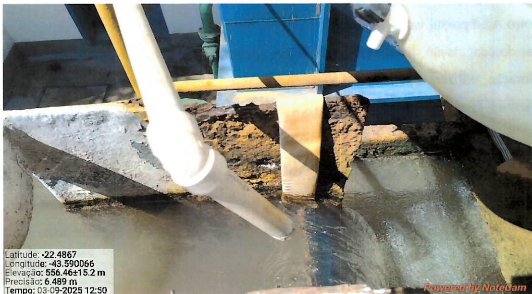
Foto 9: Entrada de água bruta na ETA Nova (nota-se a estágio avançado de corrosão da estrutura e medidor de nível inadequado)
