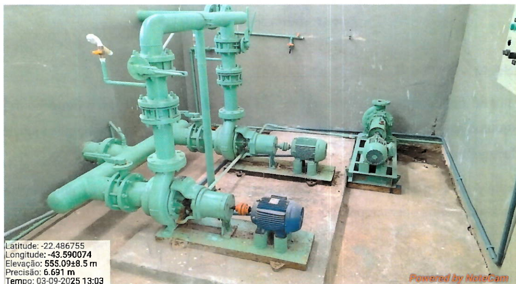
Foto 20: Bombas utilizadas na retrolavagem dos filtros.
