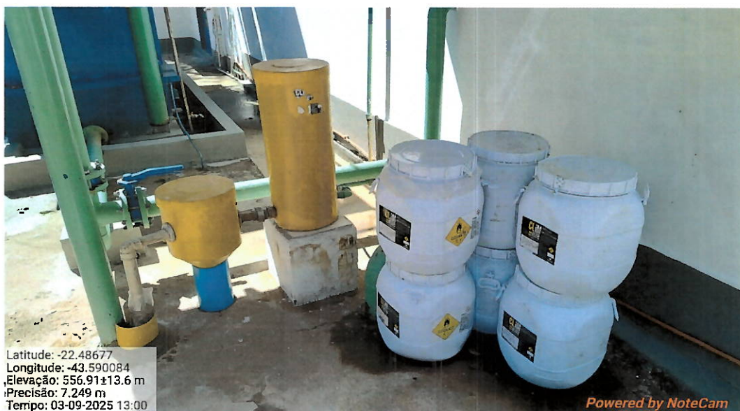
Foto 17: Sistema de cloração com utilização de hipoclorito de cálcio.
