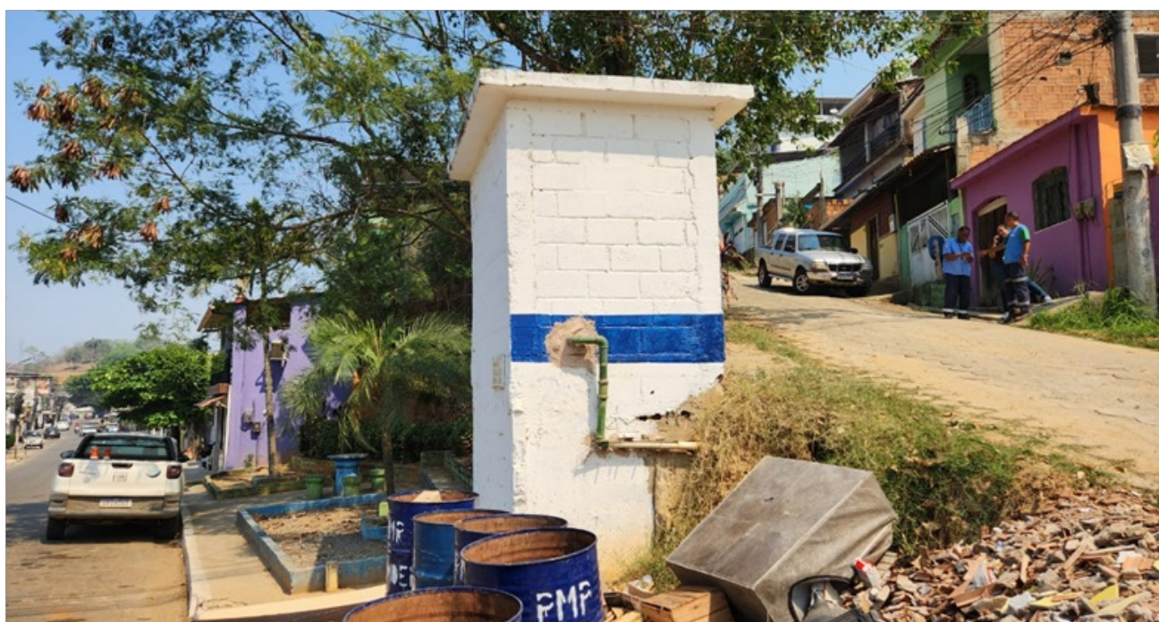
Foto 4 – Vista lateral do abrigo da elevatória
