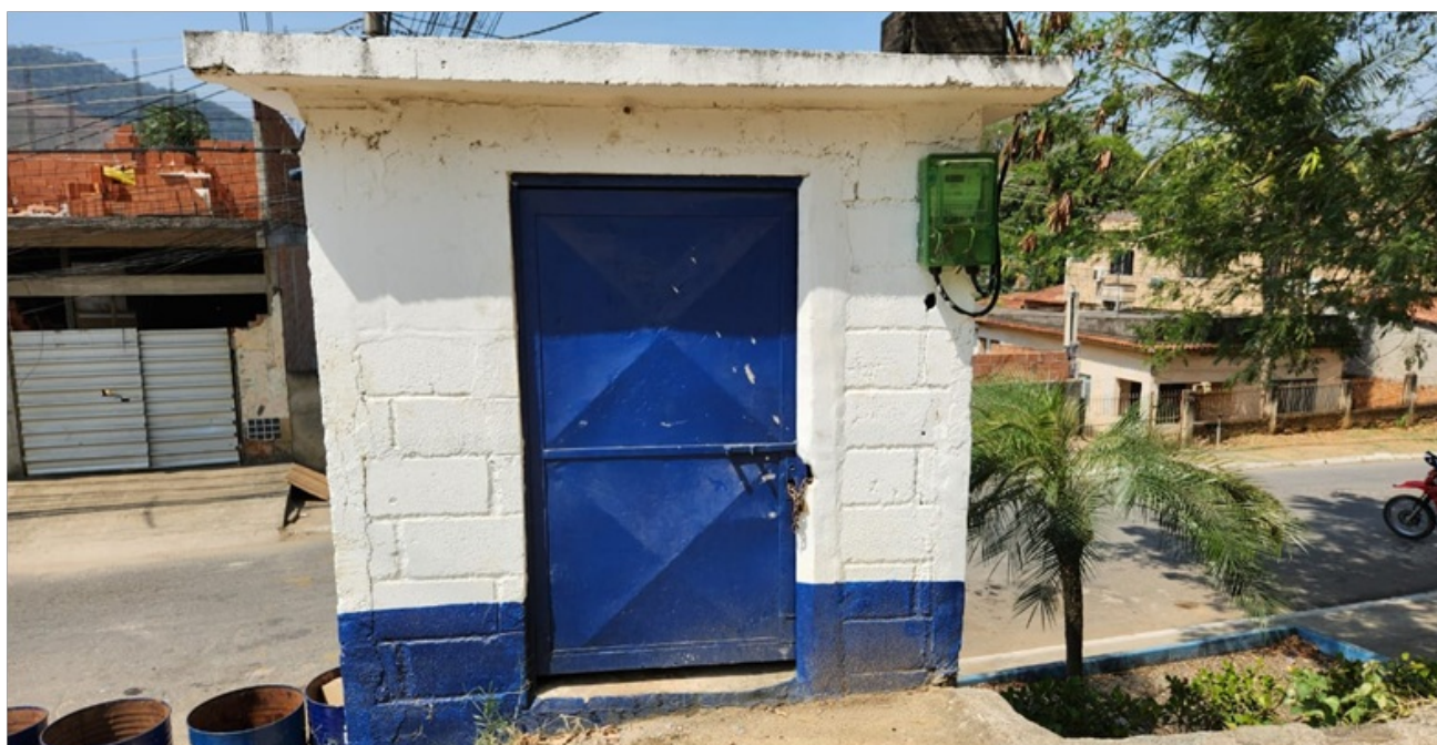
Foto 3 – Vista frontal do abrigo da elevatória
