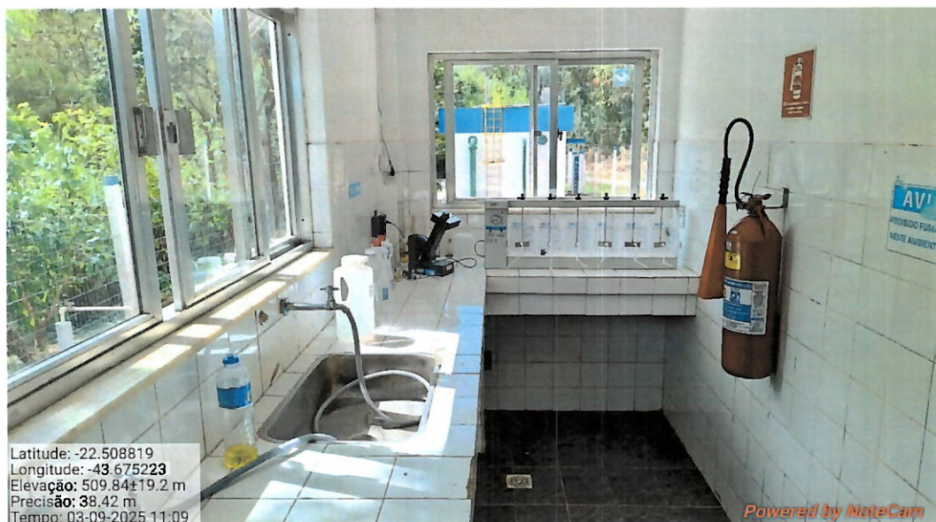
Foto 15: Laboratório da ETA.
