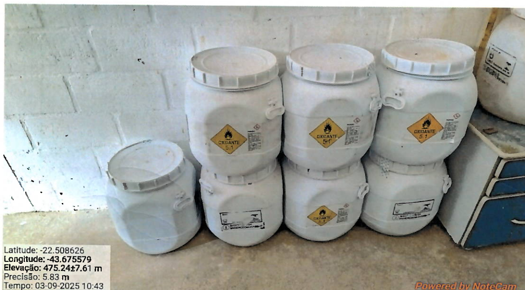
Foto 18: Armazenamento de hipoclorito de cálcio.
