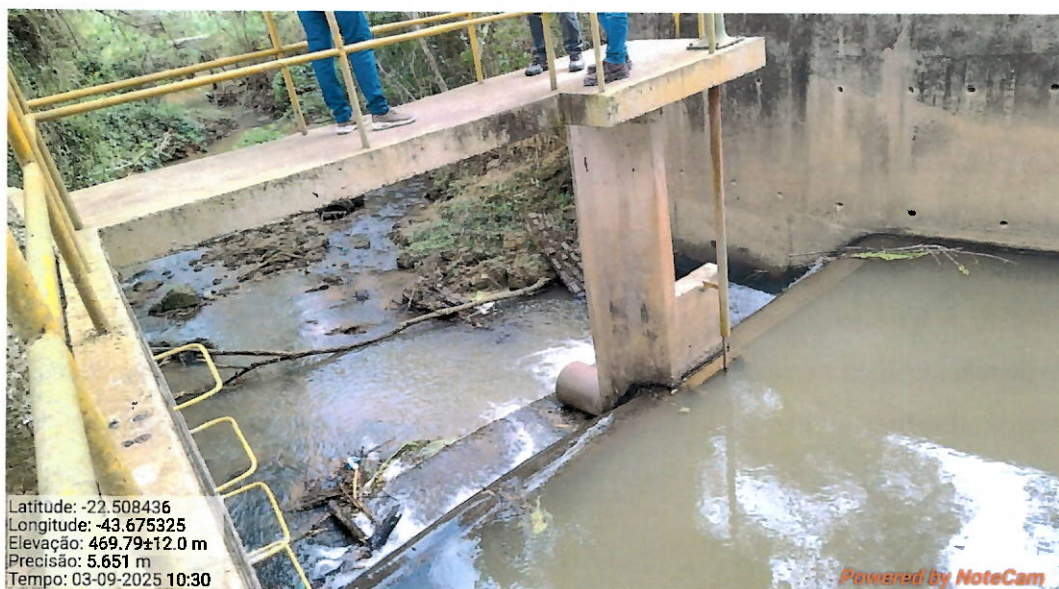
Foto 2: Ponto de captação – barragem e estrutura com guarda-corpo.
