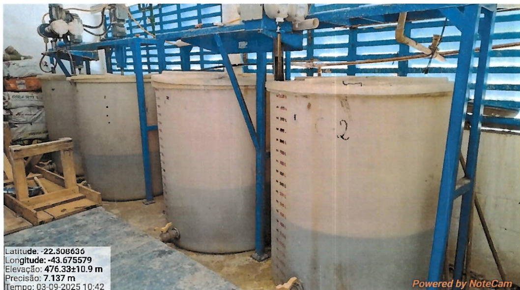
Foto 19: Armazenamento de sulfato de alumínio.
