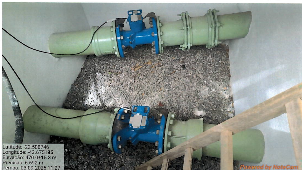
Foto 20: Novos macromedidores instalados na saída da ETA.
