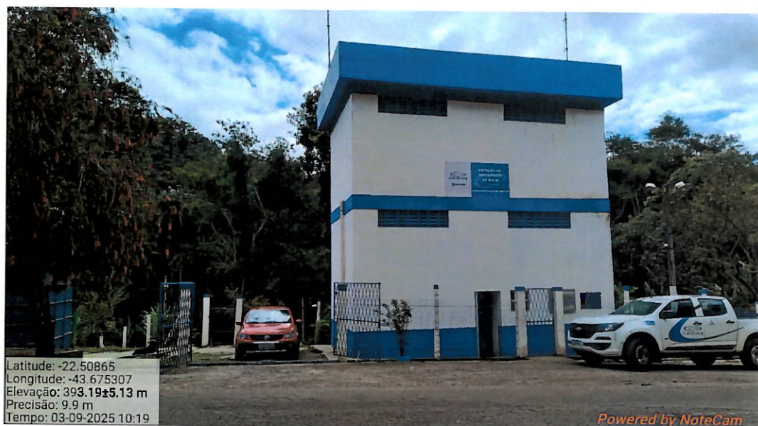
Foto 4: Fachada da ETA.
