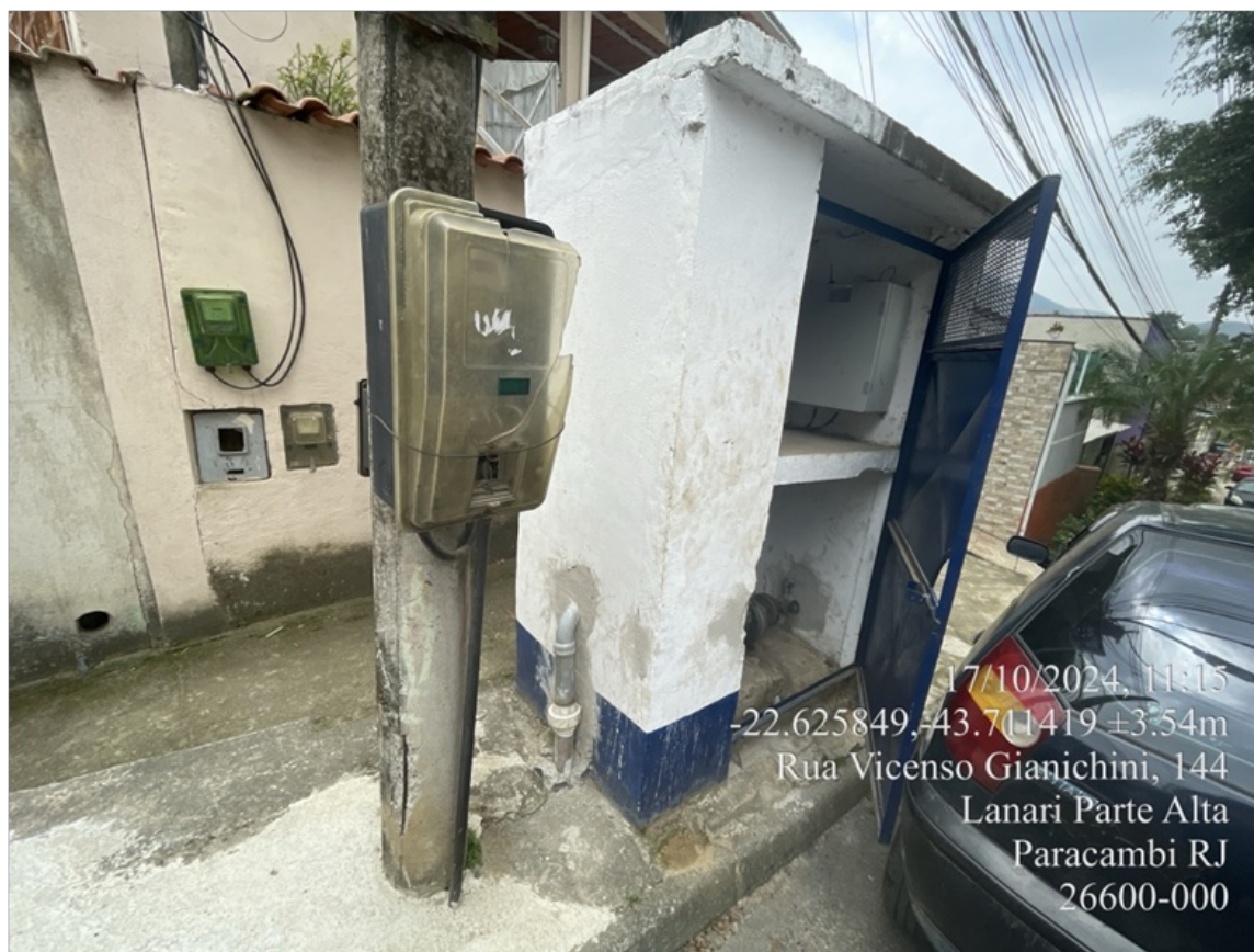
Foto 3 – Abrigo de alvenaria
