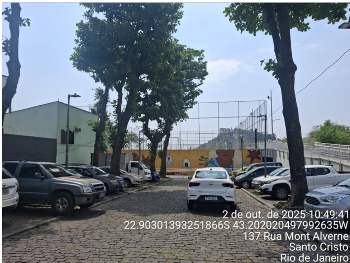
Foto 14 – Quadra localizada acima do reservatório
