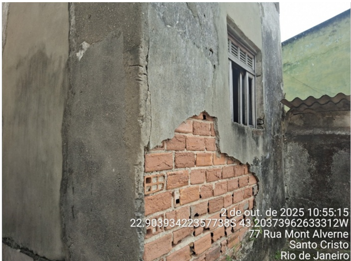
Foto 6 – Fachada casa operador
