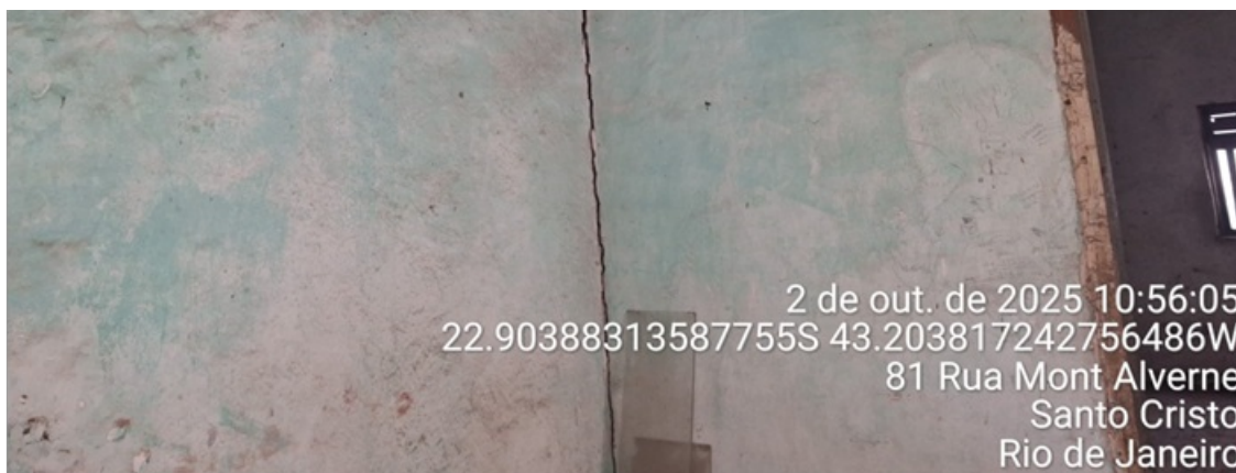
Foto 7 - Interior casa operador.
