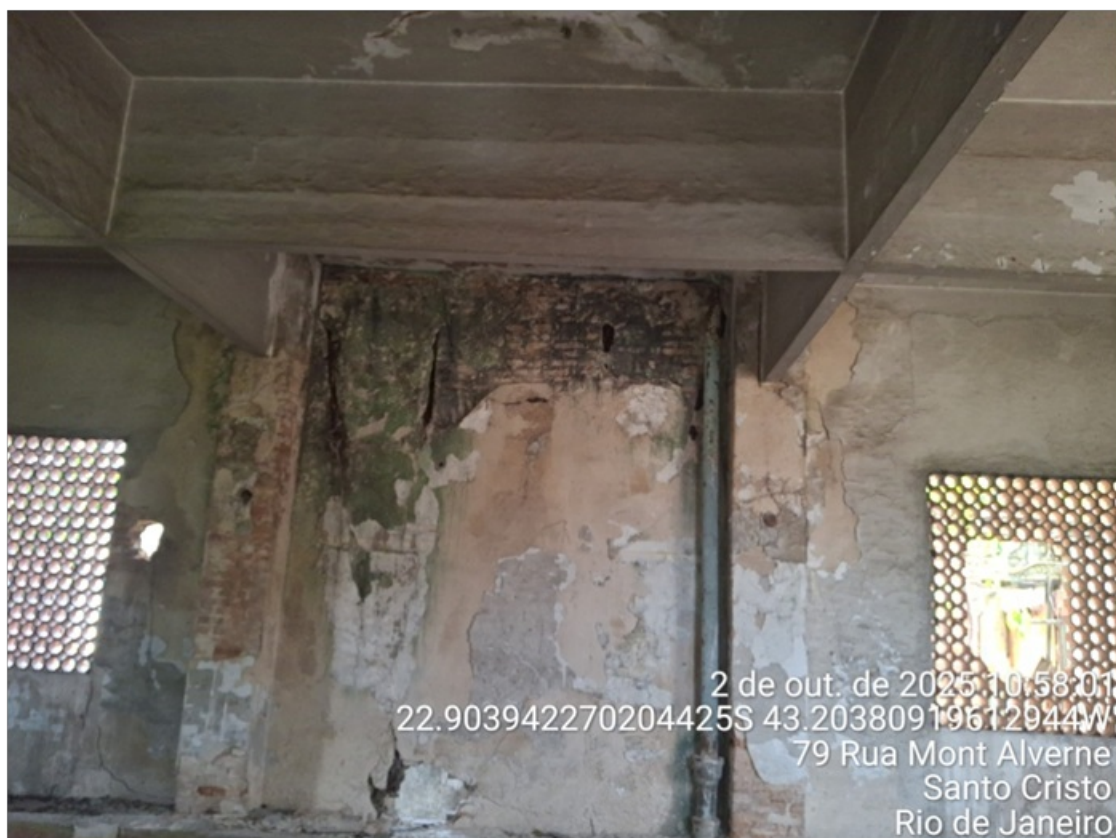
Foto 10 - Parede entorno do reservatório
