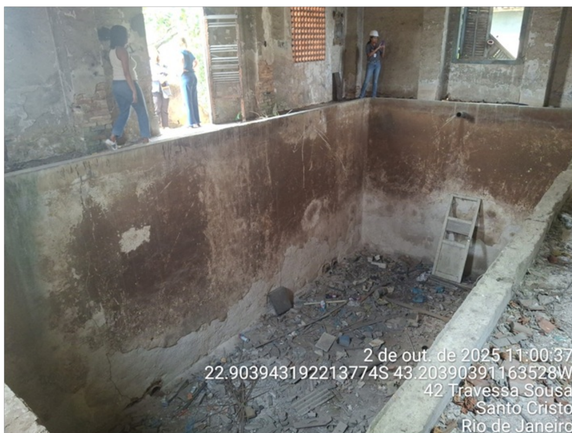
Foto 4 – Câmara do reservatório
