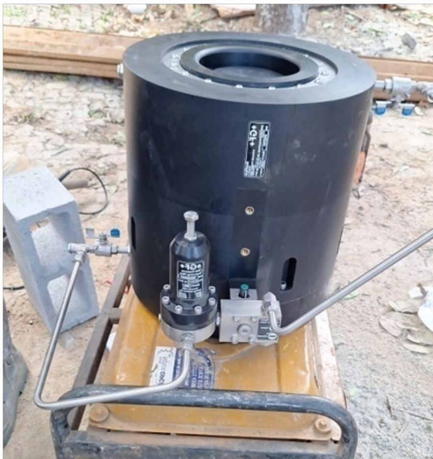
Foto 5 – Válvula redutora de pressão - VRP
