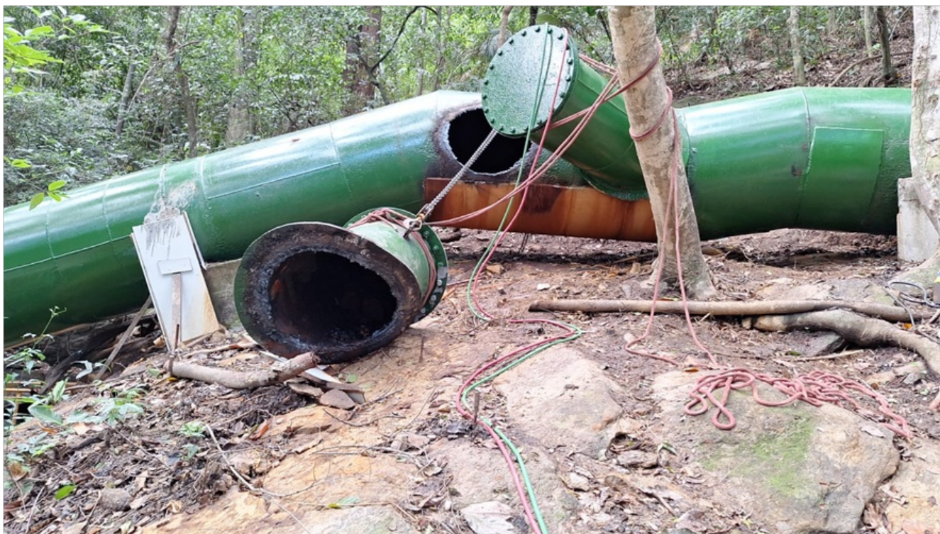
Foto 2 – Flange cego retirado para acesso à tubulação de DN 1000 mm
