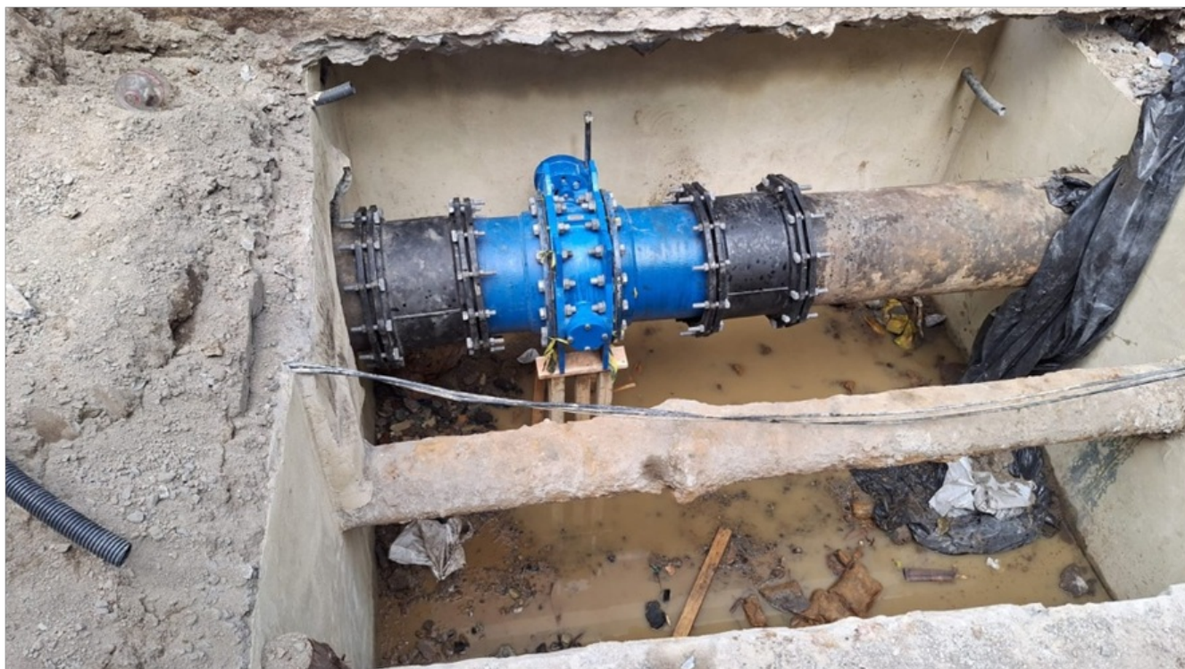
Foto 4 – Colocação de válvula borboleta com telemetria no DN 400 mm
