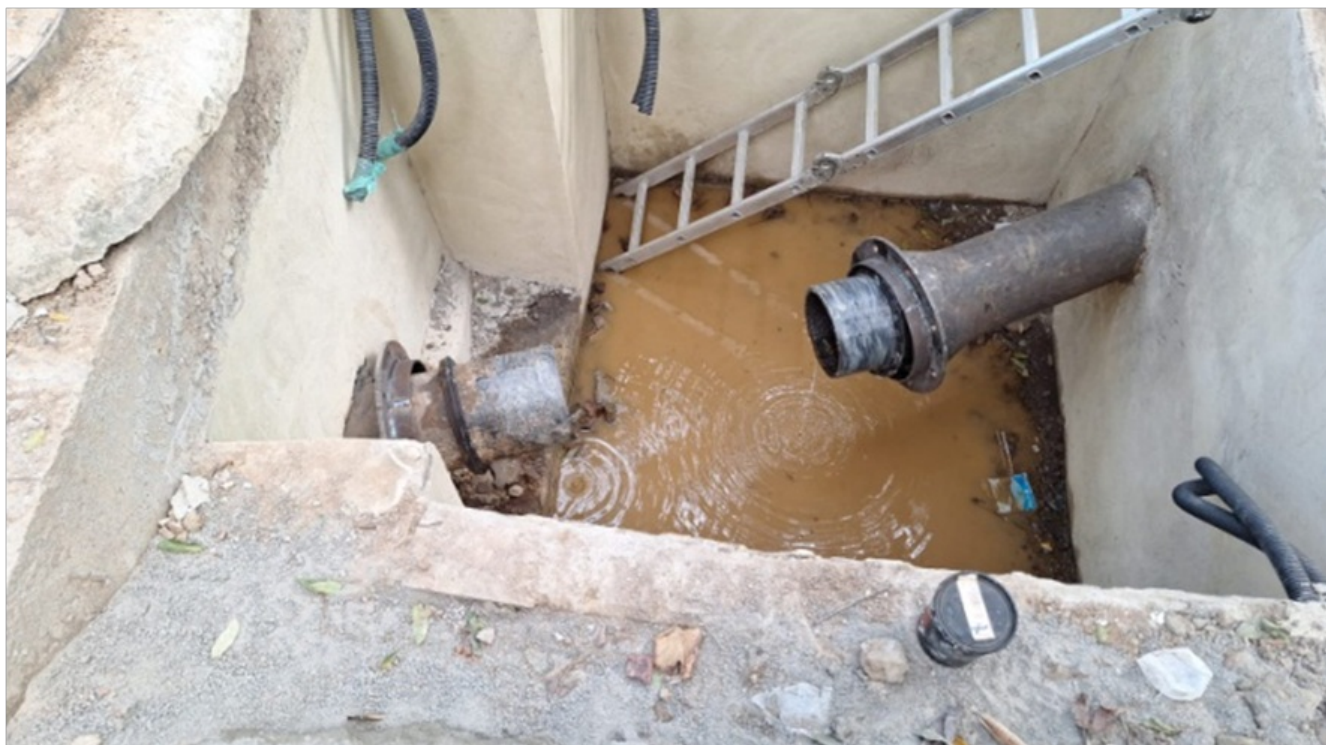
Foto 6 – Local onde será instalada a VRP - Válvula Redutora de Pressão
