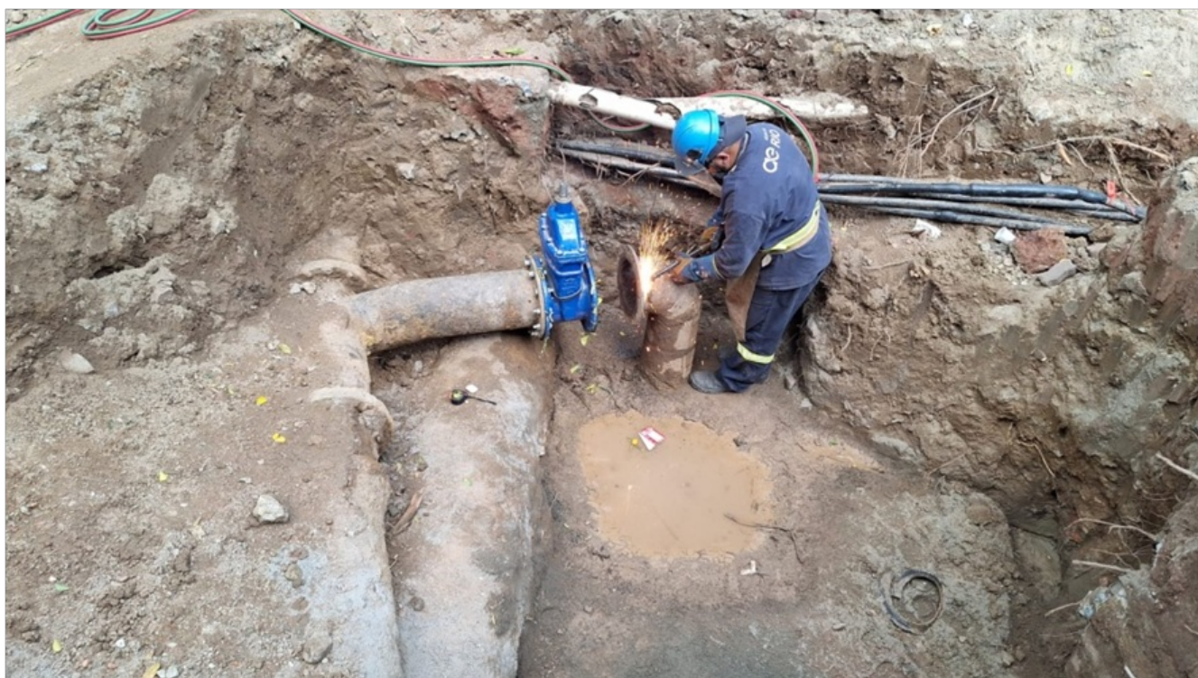
Foto 3 – Troca de válvula gaveta no 200 mm e reparo de vazamento
