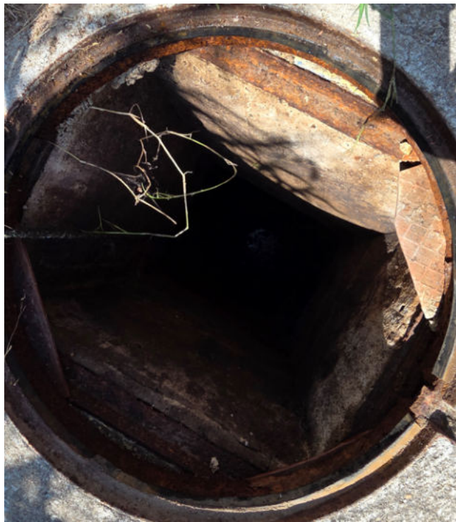
Foto 15 – Poço da chegada do esgoto com gradeamento para remoção dos sólidos
