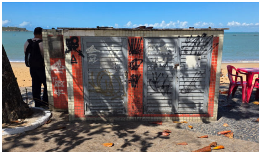
Foto 79 – Falta de identificação da EEEB
