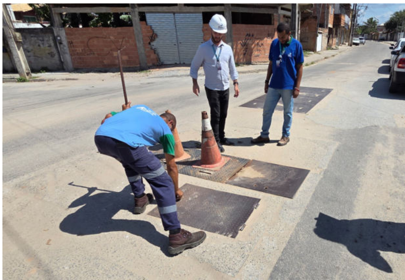
Foto 34 – Caixa receptora
