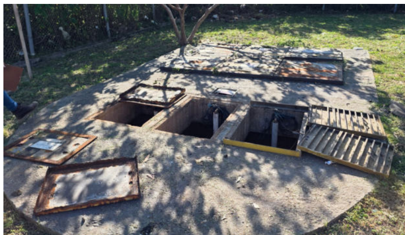
Foto 56 – Caixa receptora
