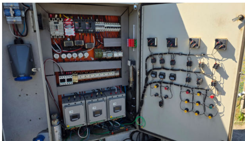
Foto 106 – Painel elétrico da EEEB
