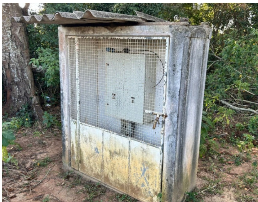
Foto 111 – Abrigo da EEEB
