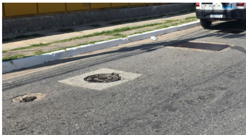
Foto 5 – Caixa receptora
