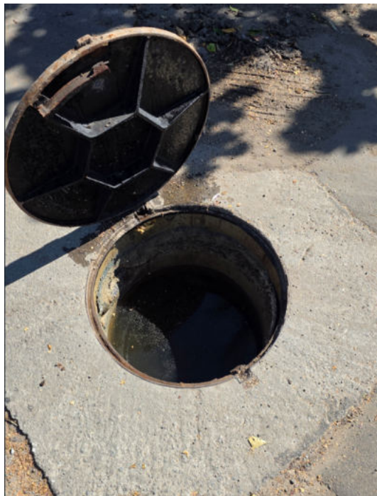
Foto 110 – Poço de visita interceptor
