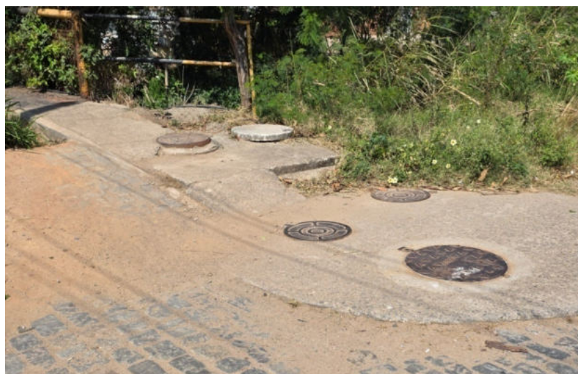
Foto 27 – Caixa receptora
