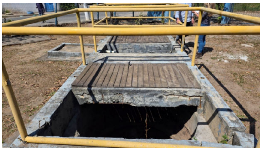
Foto 30 – Poço da chegada do esgoto
