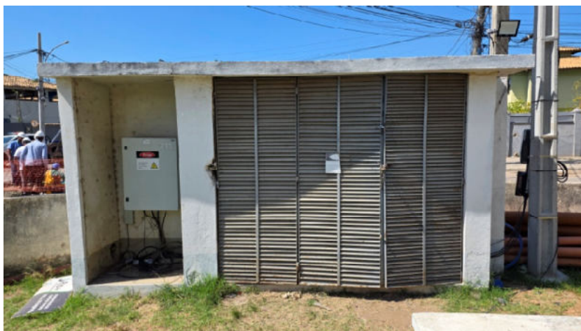
Foto 20 – Abrigo da EEEB
