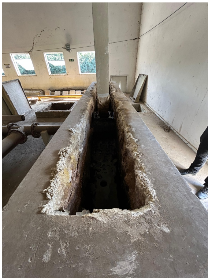
10 Chegada do esgoto aos reatores
