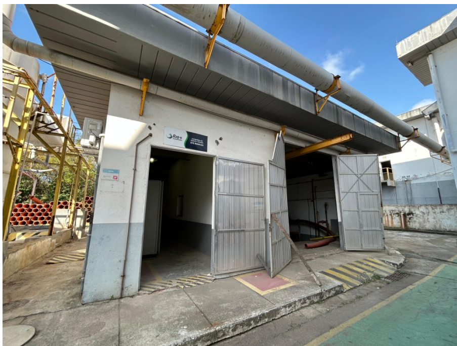
14 Elevatória de esgoto tratado
