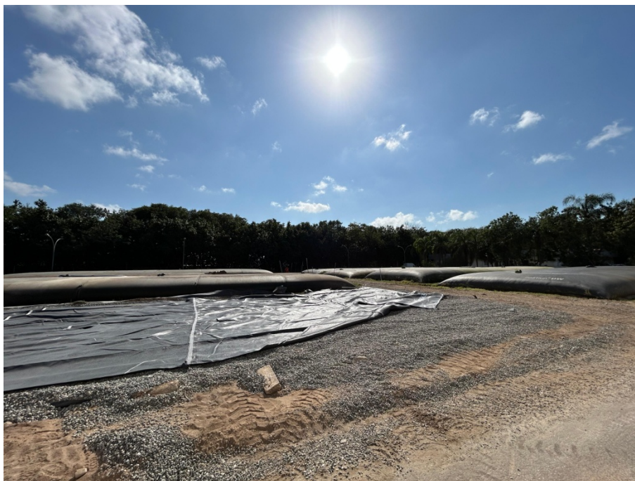
13 Local destinado aos geobags para secagem do lodo
