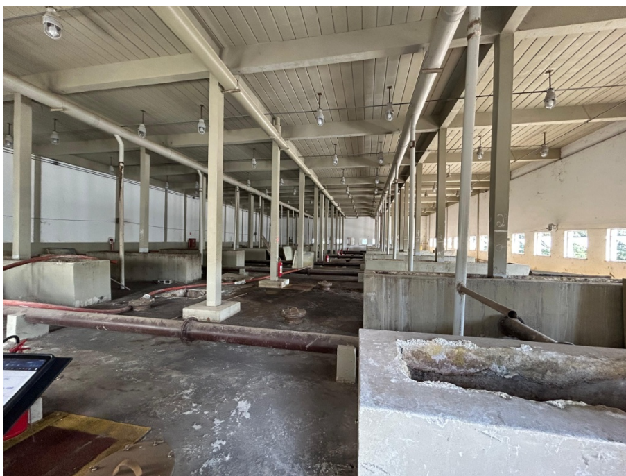
11 Laje superior com os reatores
