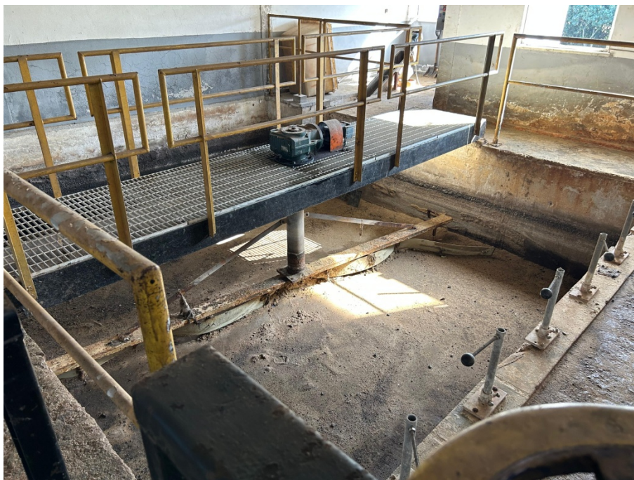
8 Caixa de areia desativada
