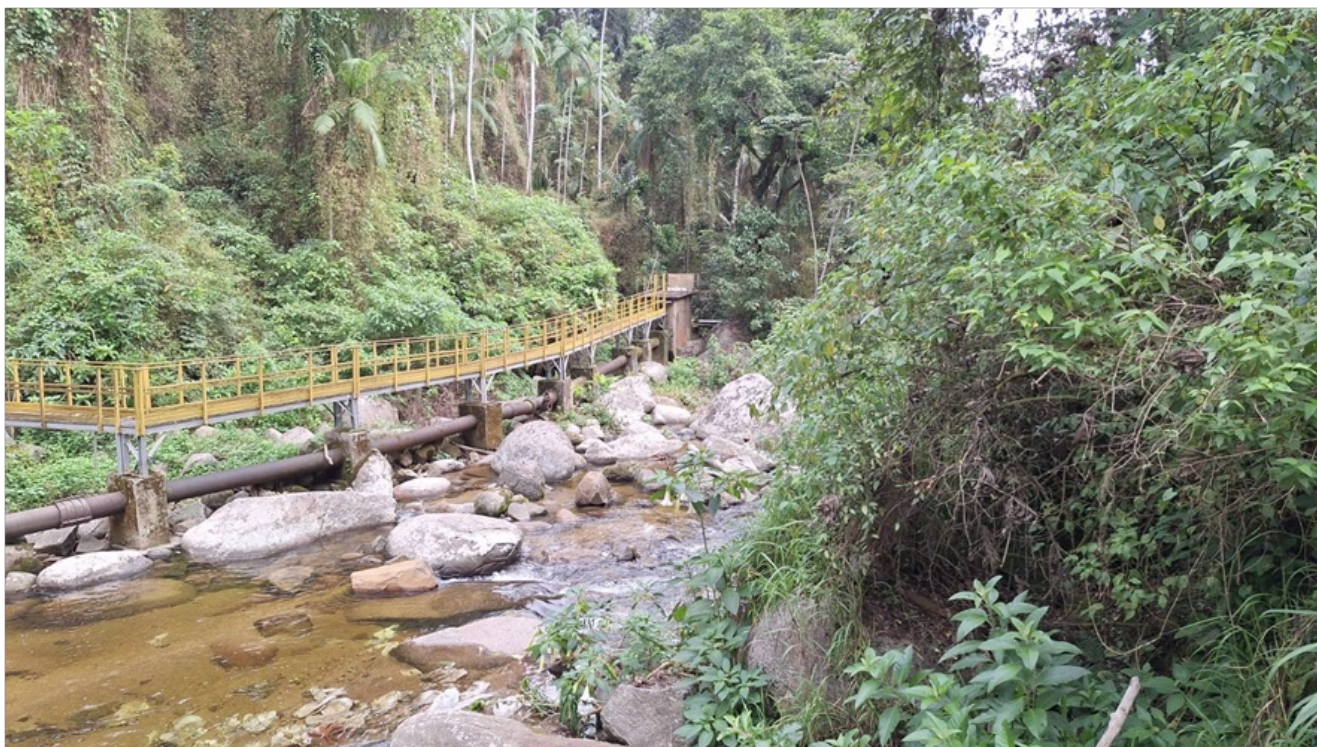
Foto 4 – Caixa desarenadora no final da passarela de acesso
