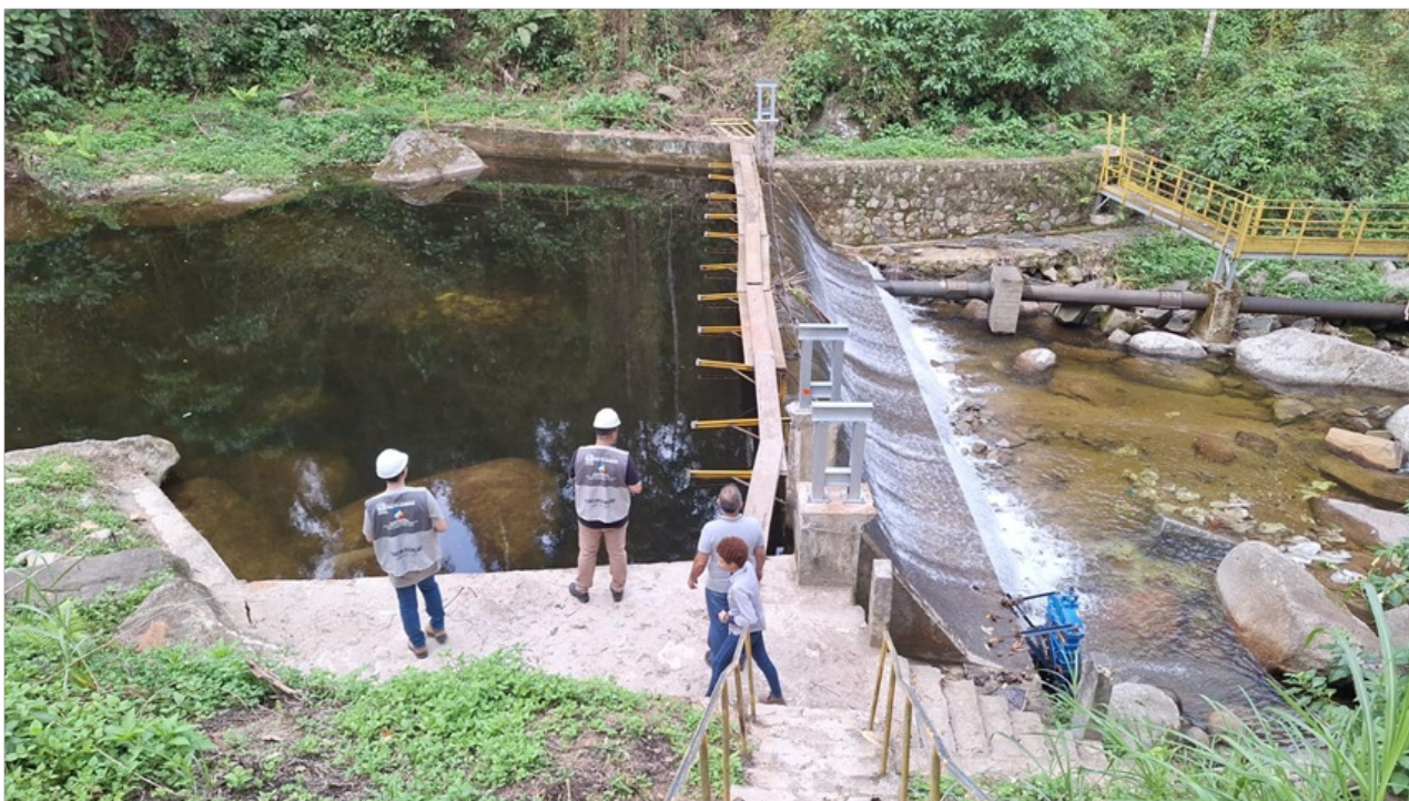
Foto 3 – Captação Pedra Branca, onde podemos verificar a qualidade do manancial ( 23° 12' 22,94" S ; 44° 45' 35,11" O ). Podemos observar a reforma da passarela de travessia, a válvula de descarga do poço e a adutora de água bruta (FºFº 200 mm)
