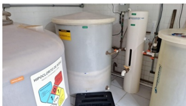
Foto 9 e 10 – Sistema de produção de hipoclorito de sódio a partir da salmora e dosagem do produto químico na água tratada
