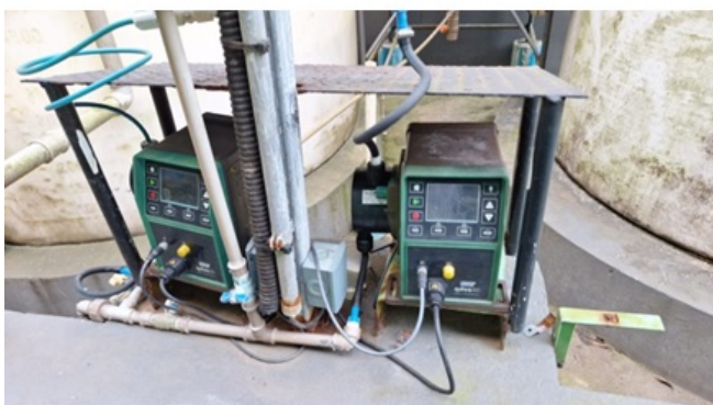
Foto 11 e 12 – Vista do dosador de PAC com o novo tanque do produto, que tem fundo cônico para drenagem.
