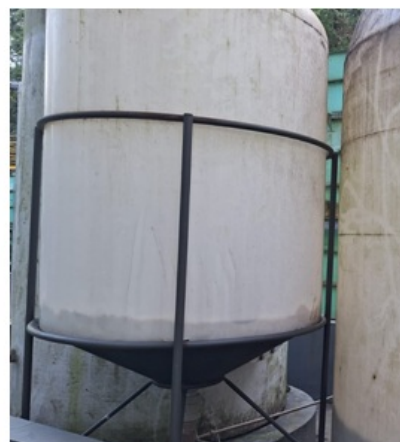
Foto 11 e 12 – Vista do dosador de PAC com o novo tanque do produto, que tem fundo cônico para drenagem.
