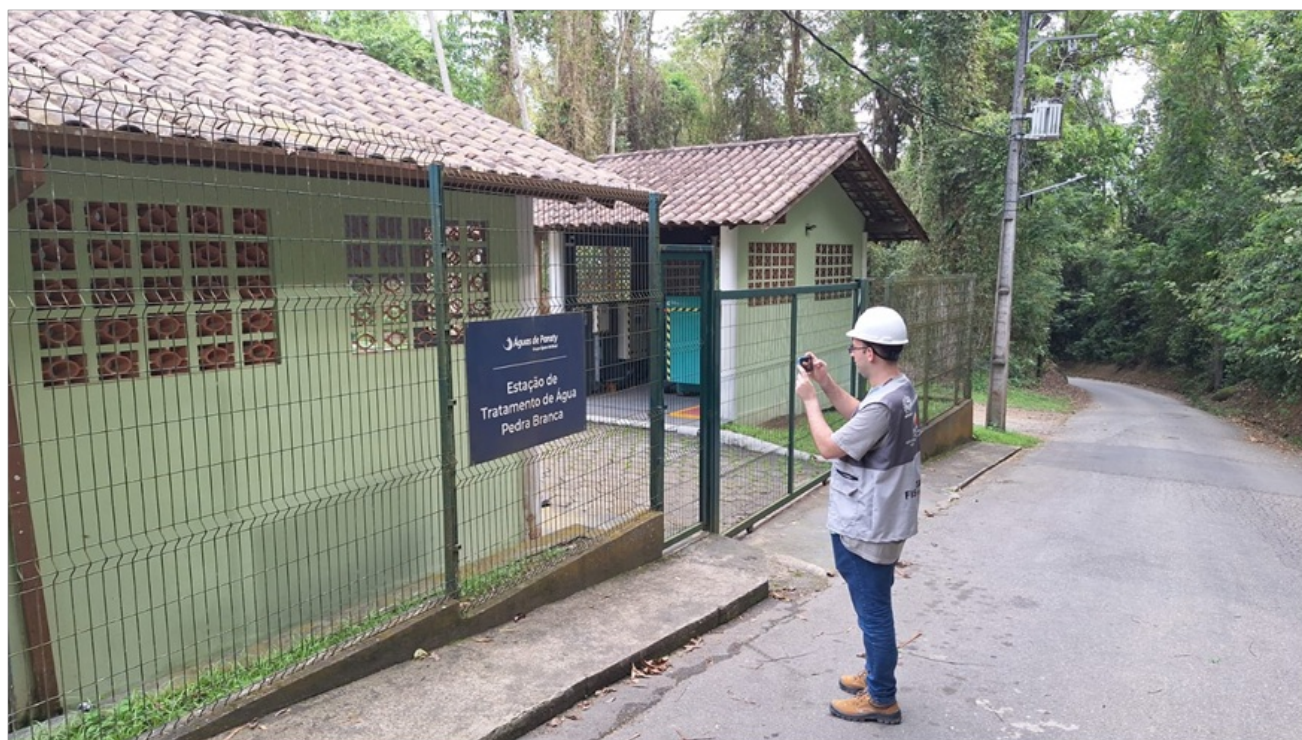
Foto 2 – Vista da entrada da ETA Pedra Branca com portão, placa de identificação e cerca ao redor.
