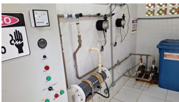
Foto 9 e 10 – Sistema de produção de hipoclorito de sódio a partir da salmora e dosagem do produto químico na água tratada
