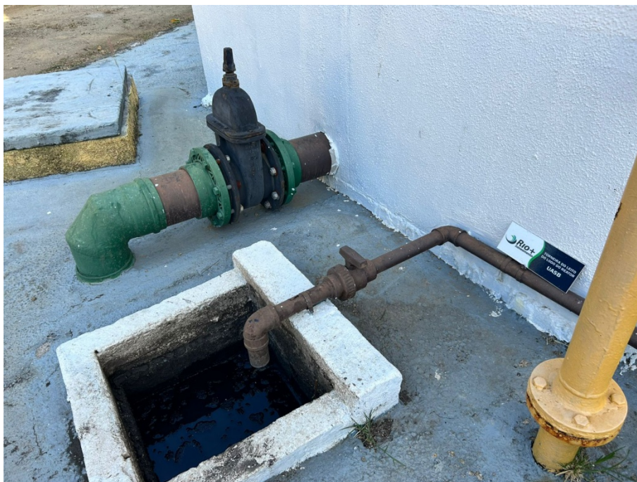
Foto 12 -Torneira do leito do lodo do reator UASB
