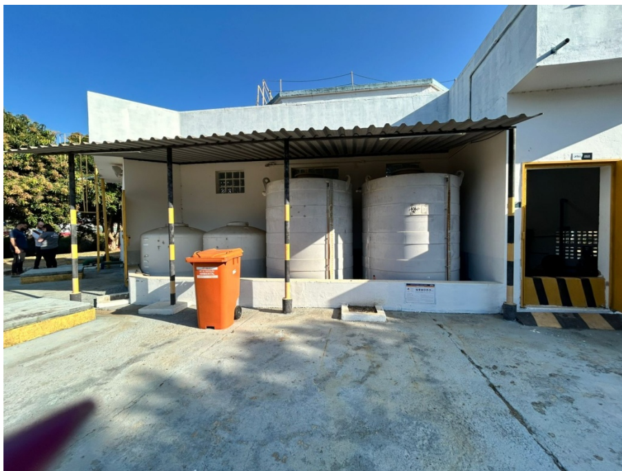
Foto 13 - Tanques de produtos químicos
