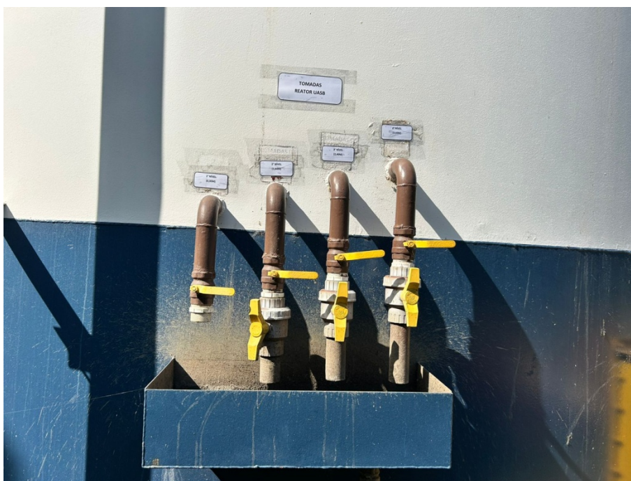
Foto 07 - Tomadas do reator UASB (1º nível, 2º nível, 3º nível e 4º nível)
