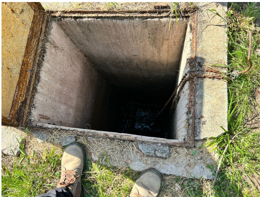
Foto 02 - Entrada do esgoto com gradeamento grosseiro do tipo cesto
