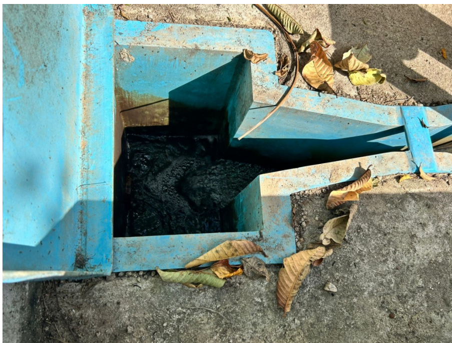
Foto 13 - Saída do esgoto tratado e clarificado
