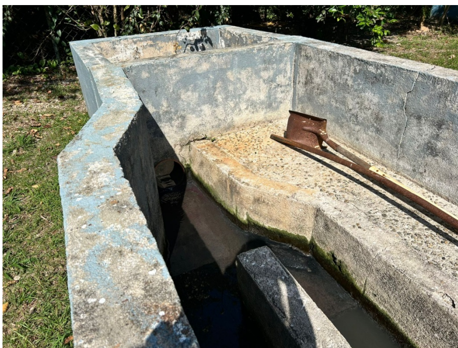
Foto 03 - Desarenador da unidade
