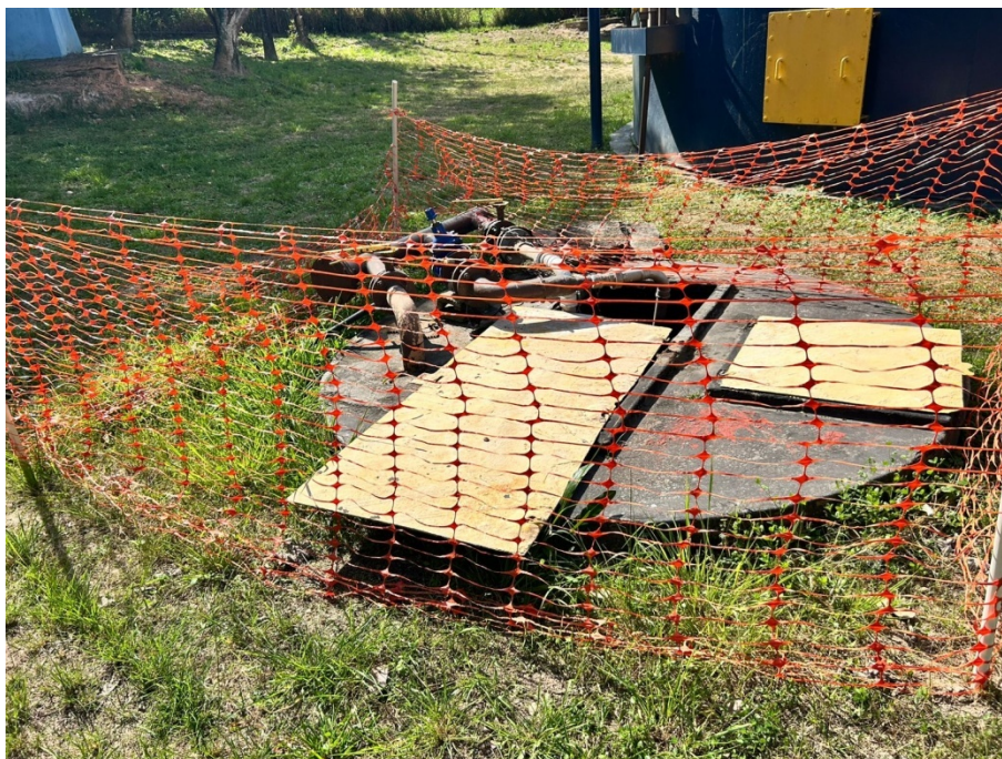
Foto 06 - Elevatória de esgoto pré tratado
