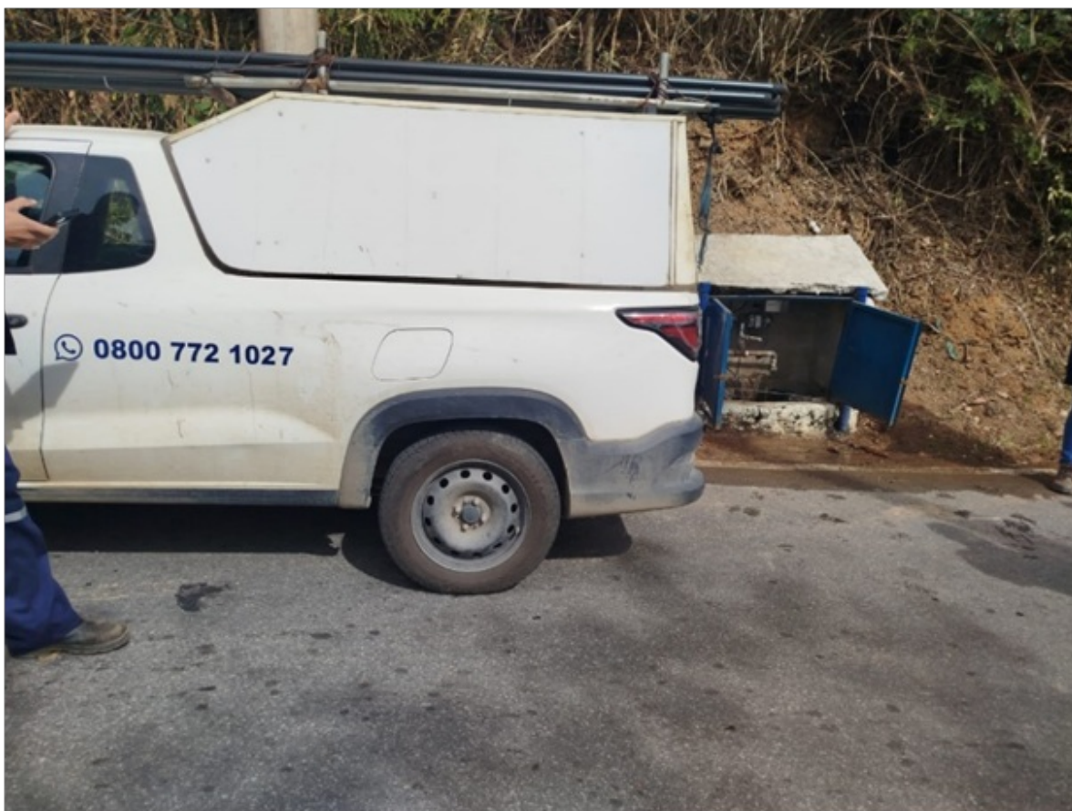
Foto 6 Veículo da manutenção executando o reparo
