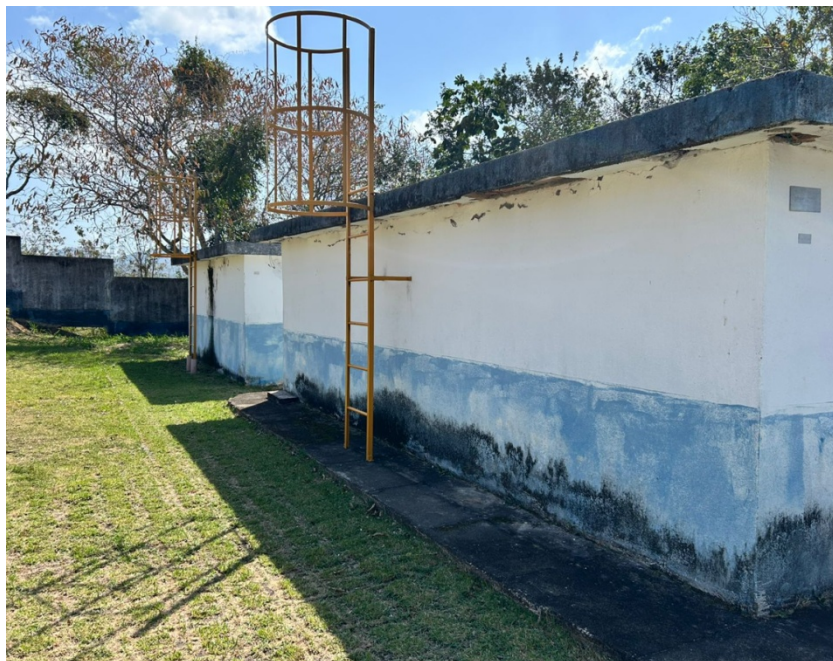
Foto 18 – Visualização das câmaras do reservatório e escadas de acesso
