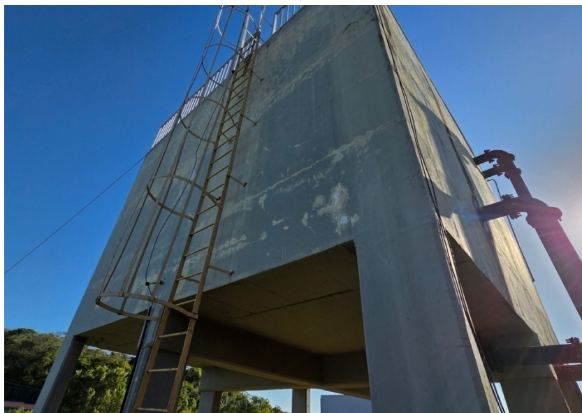
Foto 14 – Escada de acesso ao reservatório
