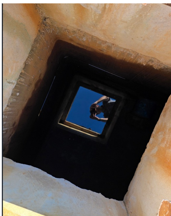
Foto 3 – Tampa de acesso ao reservatório
