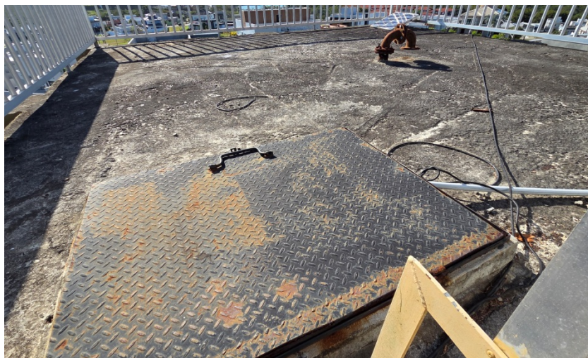
Foto 9 – Tampo de acesso ao reservatório
