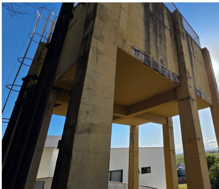
Foto 10 – Escada de acesso ao reservatório
