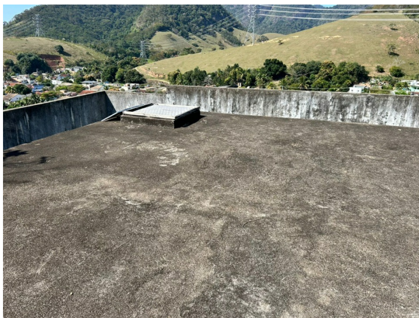
Foto 19 – Laje e caixa de inspeção fechada
