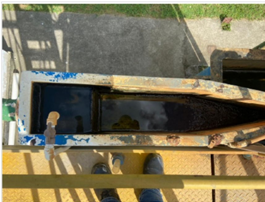
Figura 7 - Entrada de água na ETA
