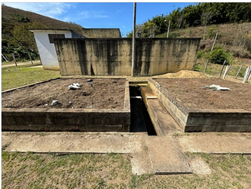
Figura 11 - Leito de secagem desativado
