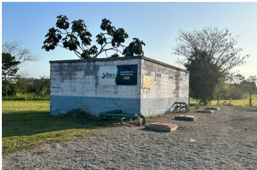
Foto 10 – Identificação da EEAT
