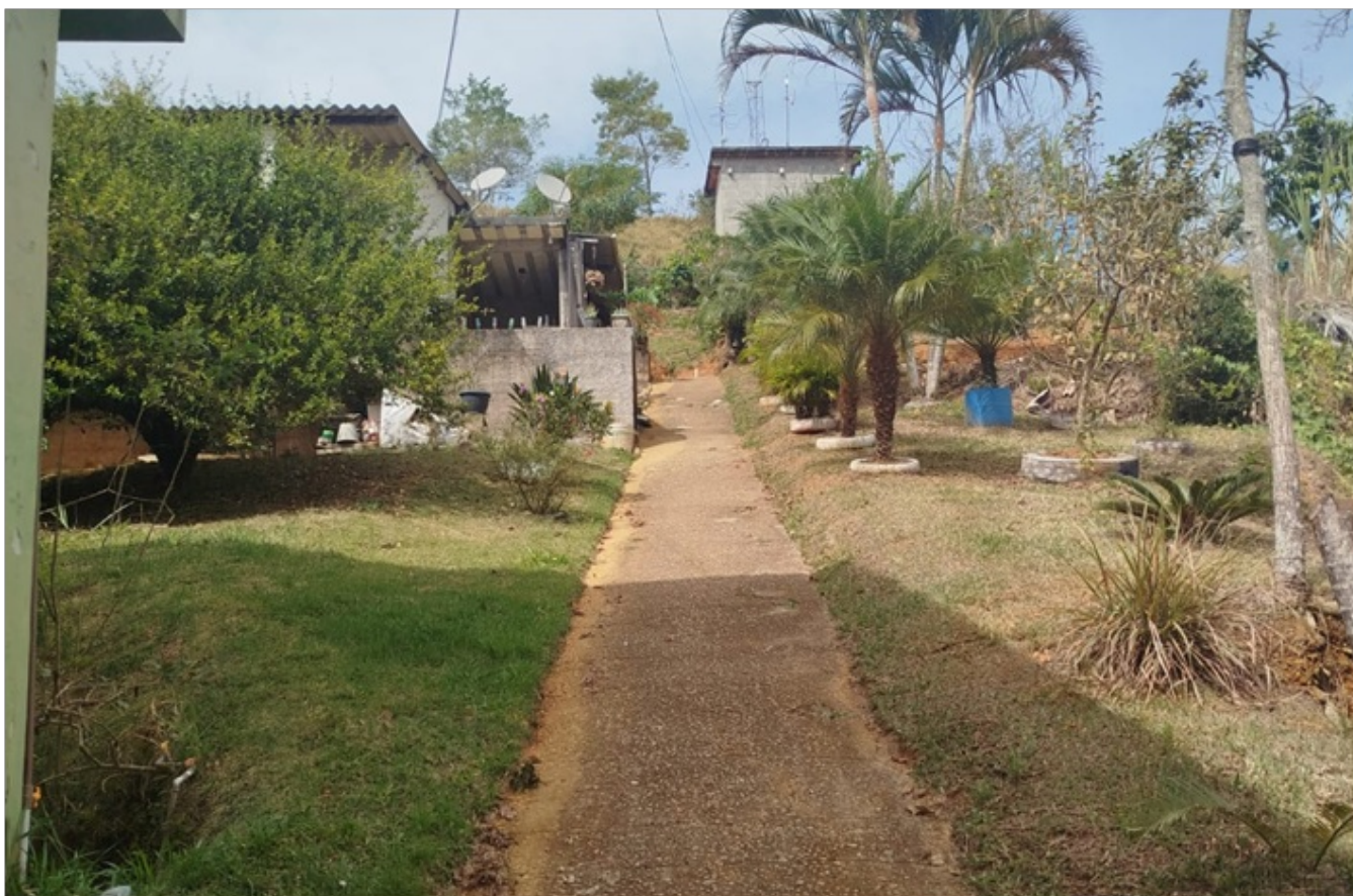
Foto 6 Rampa de acesso ao Reservatório
