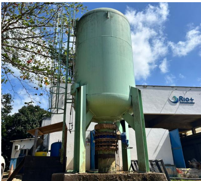
Foto 13 – Reservatório hidropneumático
