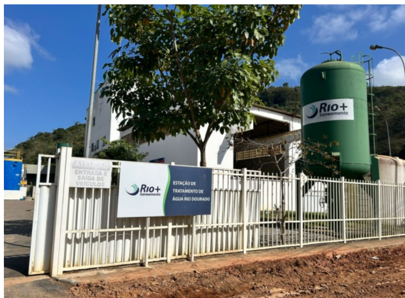
Foto 15 - Identificação da ETA Rio Dourado
