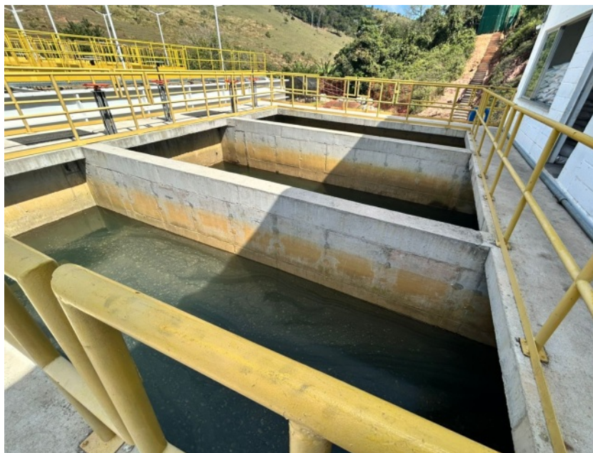
Foto 21 - Câmaras de filtração
