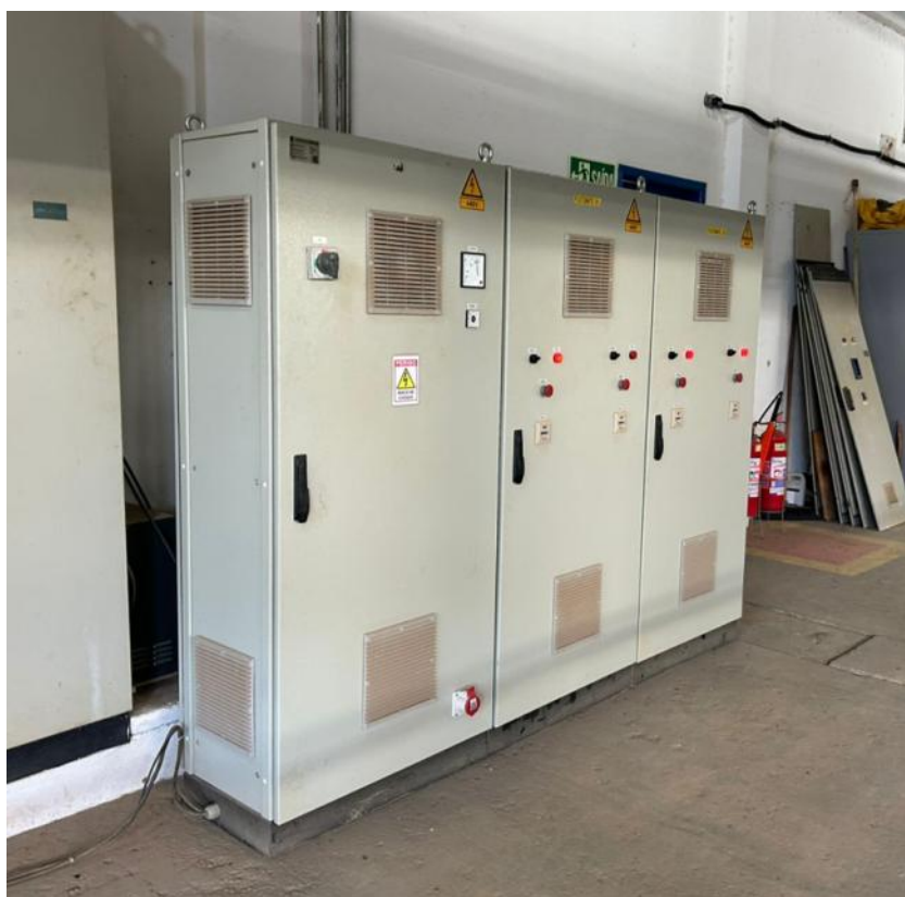
Foto 8 – Paineis de automação das motobombas
