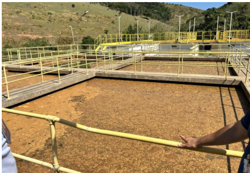
Foto 19 - Tanques de decantação
