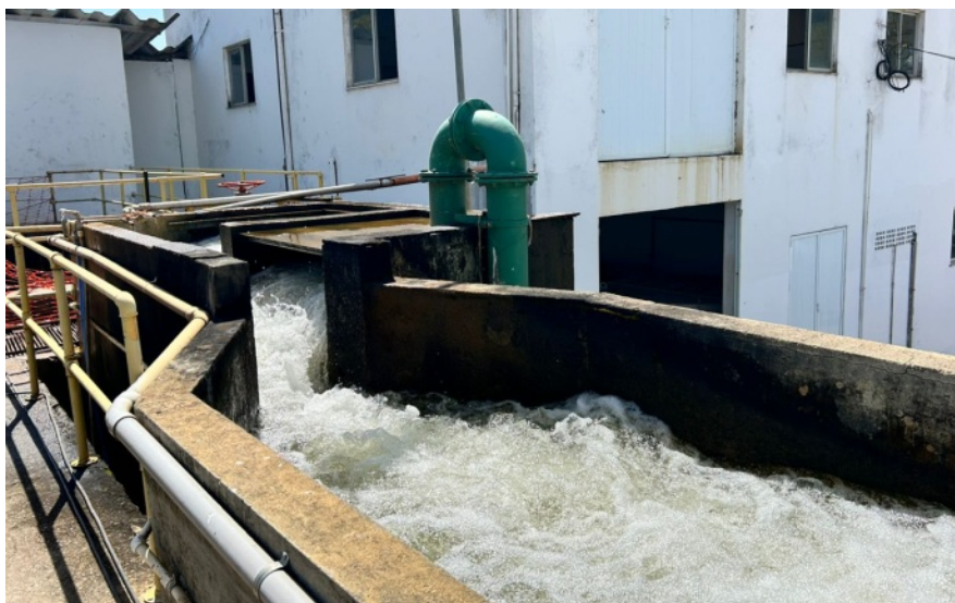
Foto 16 – Adutora de água bruta na ETA
