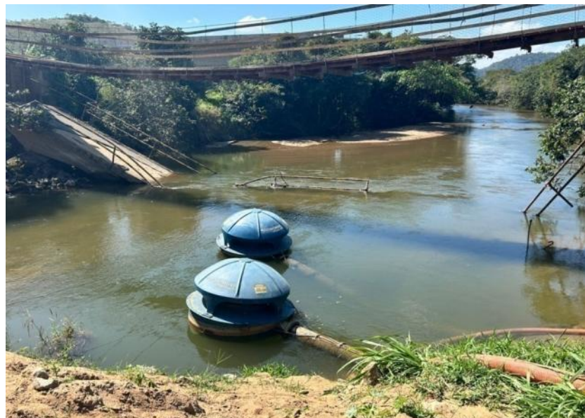
Foto 2 - Captação no Rio Macaé
