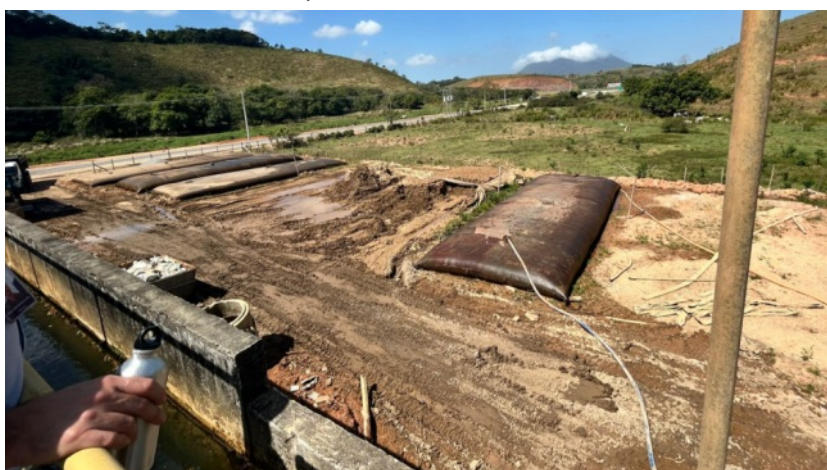
Foto 22 – Armazenamento do lodo gerado
