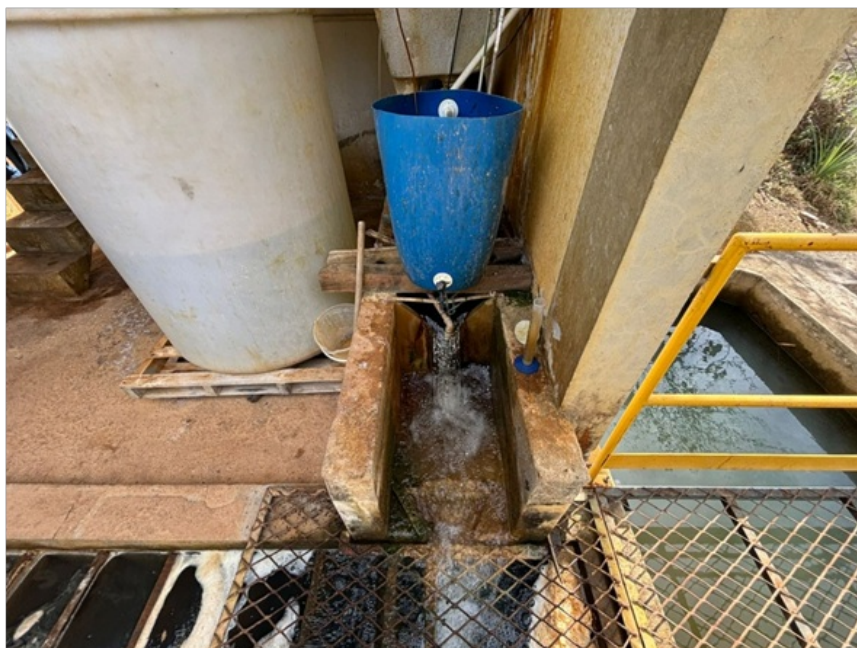
Figura 5 - Entrada de água na ETA
