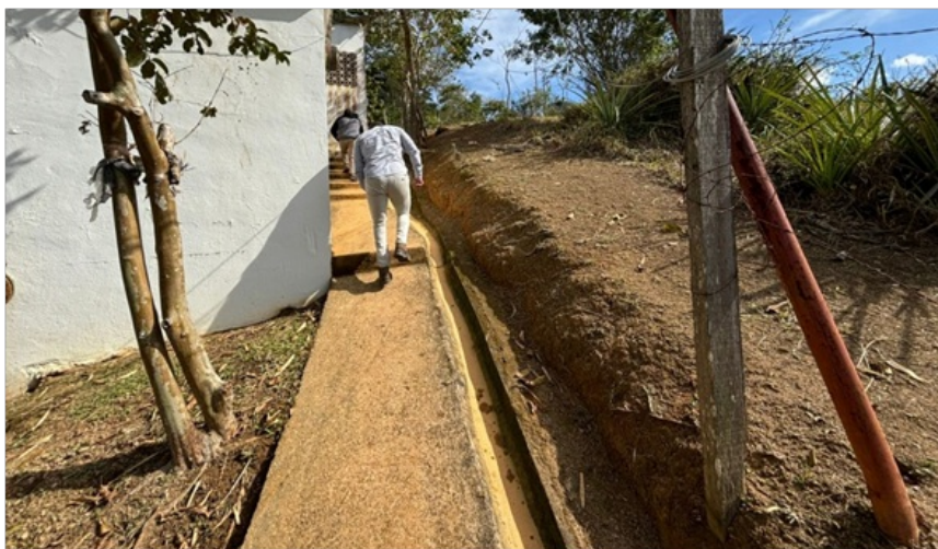
Figura 4 – Acesso a Unidade
