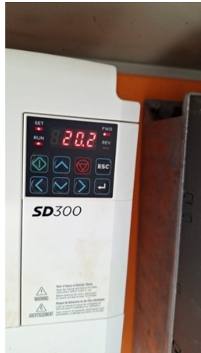
Foto 3 e 4 – Vista interna do quadro elétrico da EEE com os inversores de frequência
