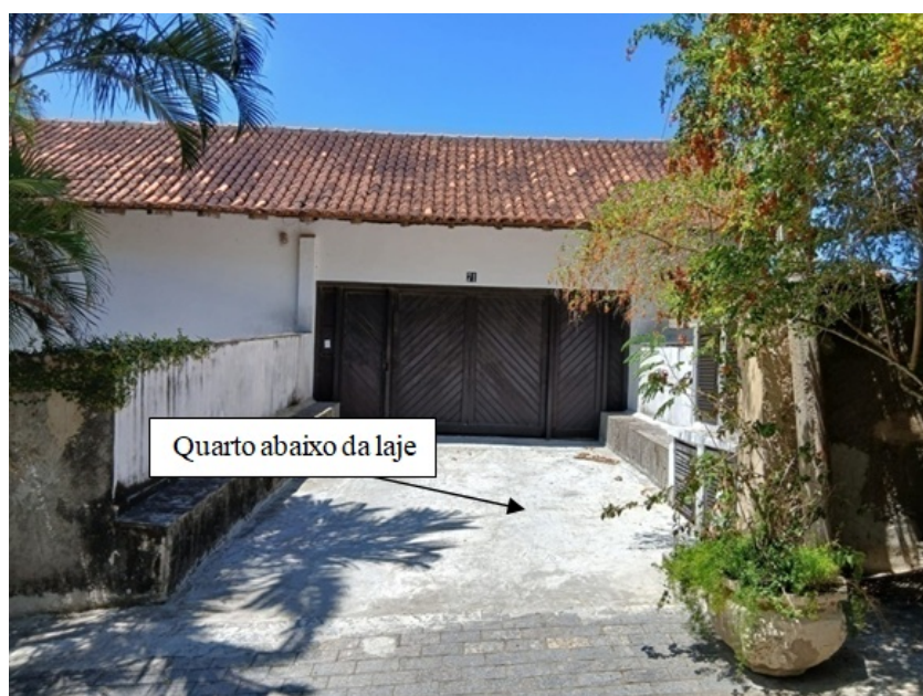
Foto 2 – Laje que dá acesso a garagem (fachada principal)
