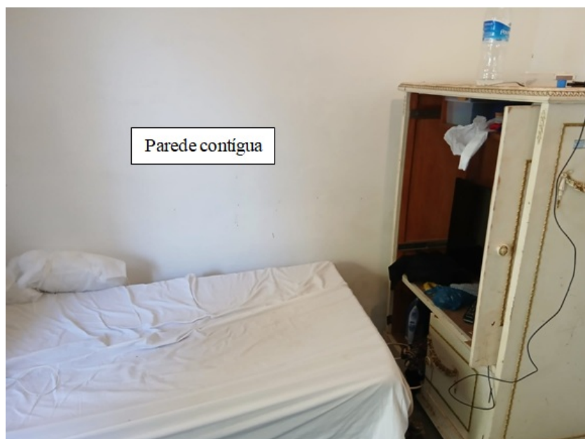
Foto 9 – Parede do quarto contígua a cortina atirantada
