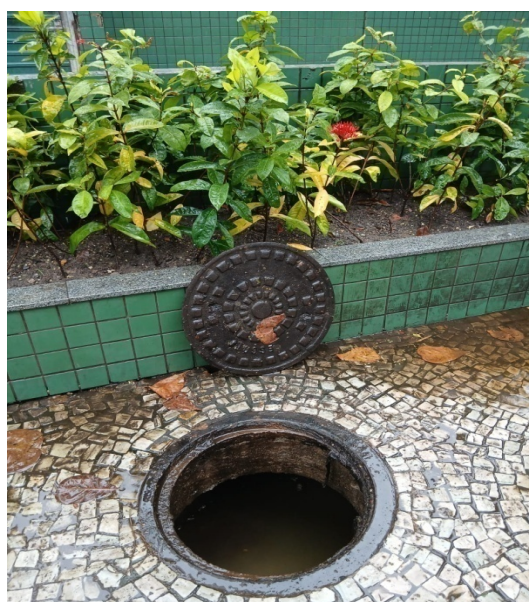
Foto 5 – Terceiro PV da Rede de Esgotamento Sanitário
