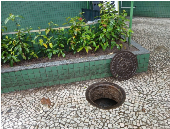
Foto 1 – Primeiro PV da Rede de Esgotamento Sanitário, onde há o deságüe do efluente do condomínio
