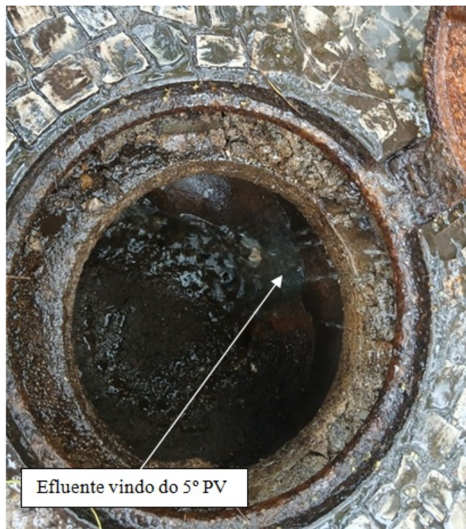
Foto 8 – Último PV da Rede de Esgotamento Sanitário – PV de ligação com a Galeria de Águas Pluviais
