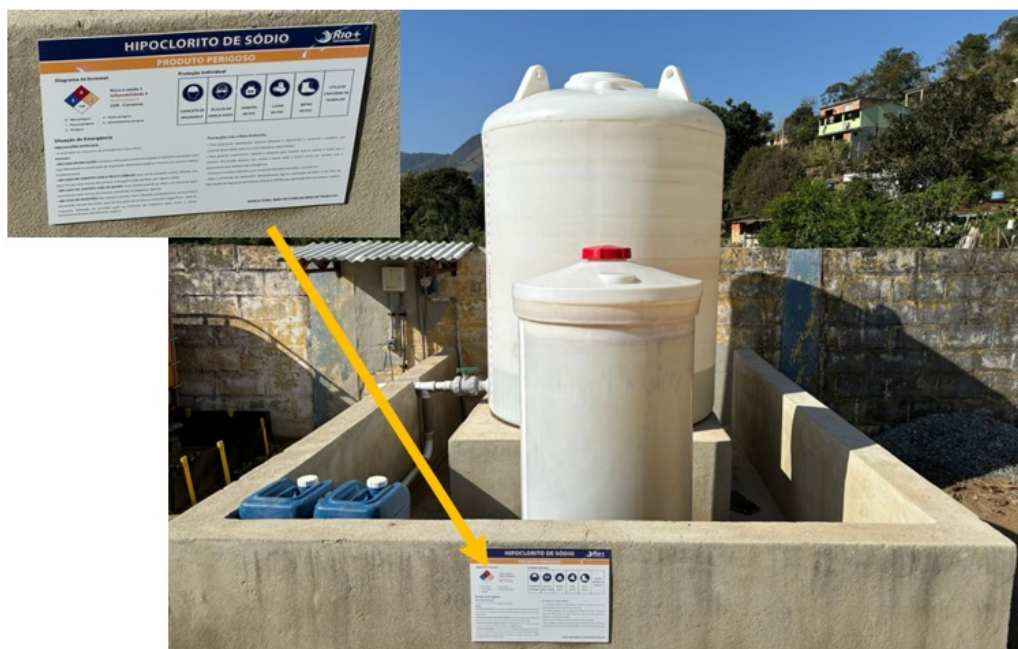
Foto 17 - Estoque de hipoclorito de sódio e bomba dosadora
