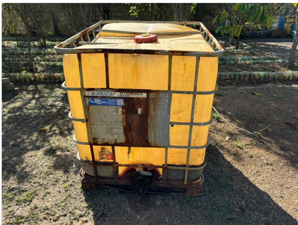
Foto 18 - Estoque de óleo diesel sem bacia de contenção em caso de possíveis vazamentos
