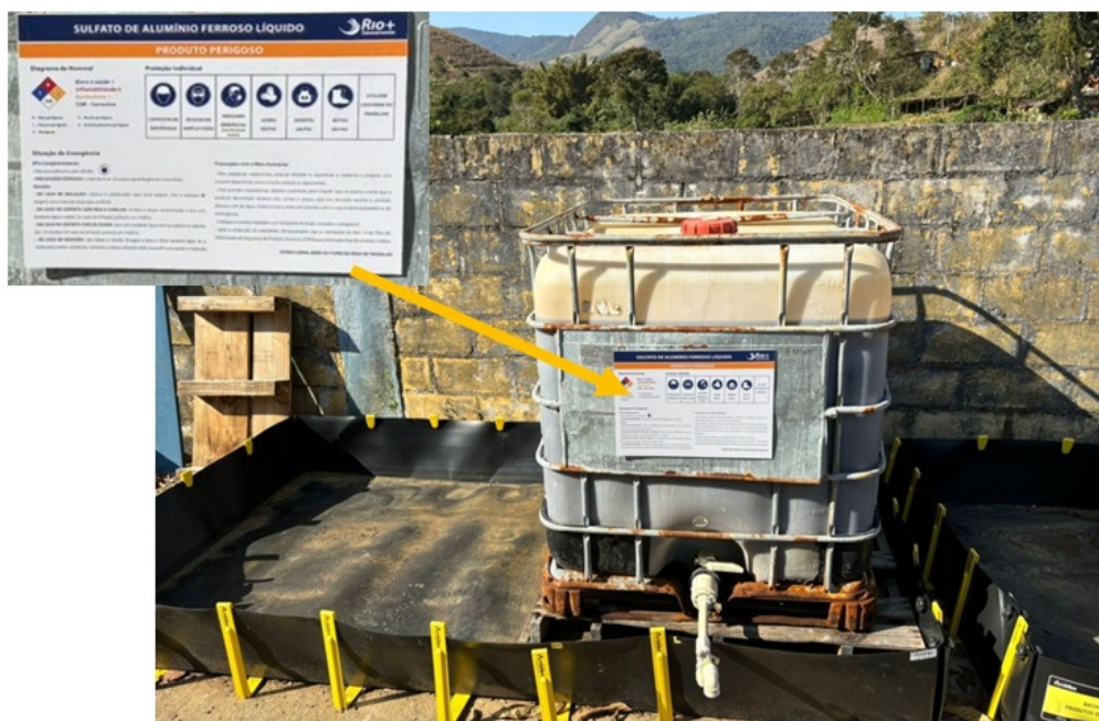
Foto 16 - Estoque de sulfato de alumínio
