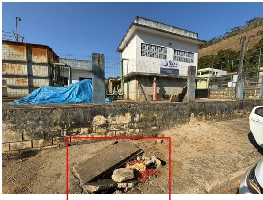
Foto 3 - Cerca danificada, calçamento precário e local da guarda da válvula e tubulação de saída da água da ETA com tampa quebrada com risco de acidente por falta de sinalização, não conformidades apontadas em relatórios anteriores.
