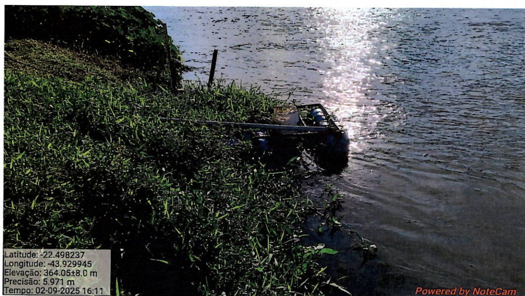
Foto 1: Ponto de captação de água bruta.
