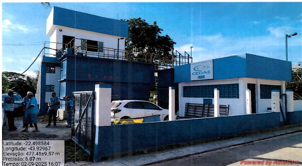
Foto 4: Fachada da ETA.
