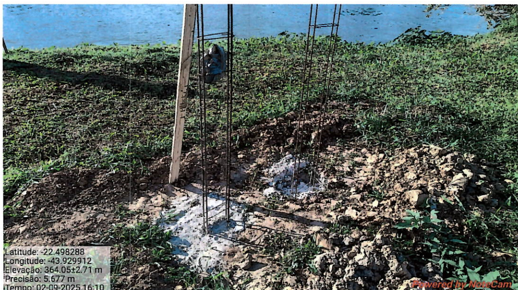
Foto 3: Fundações para construção de plataforma de acesso.
