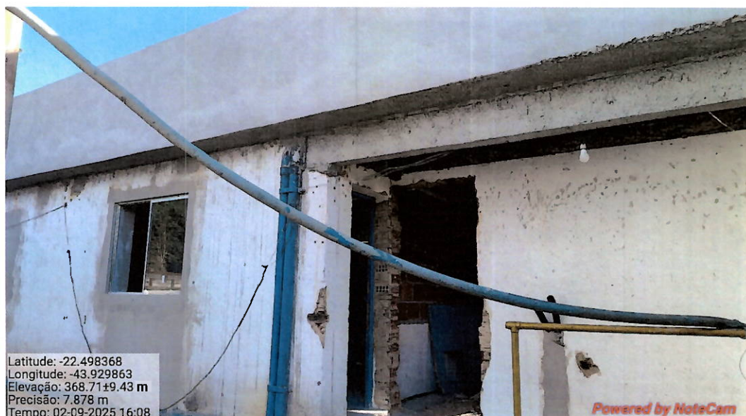
Foto 7: Prédio anexo em obras.
