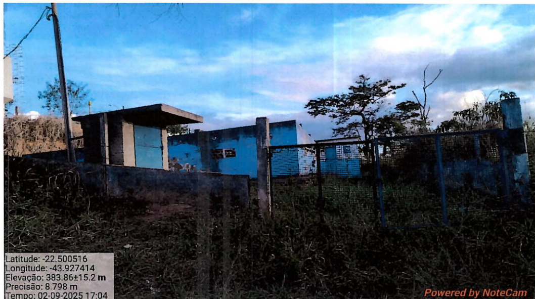
Foto 20: Acesso ao reservatório (nota-se a necessidade de limpeza de vegetação).
