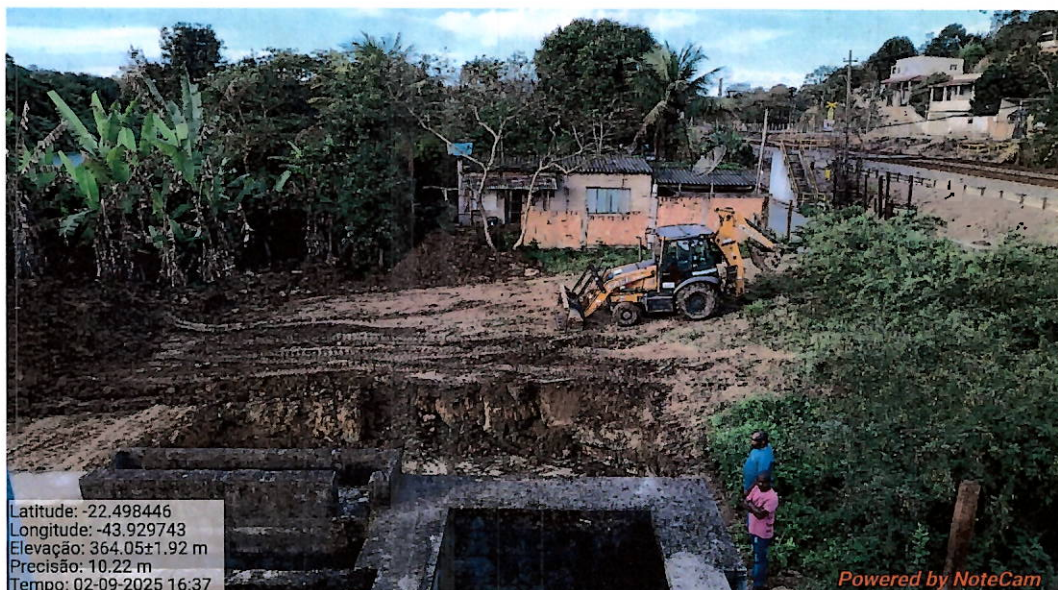
Foto 14: Obra iniciada no terreno onde será instalada a unidade de tratamento de lodo.
