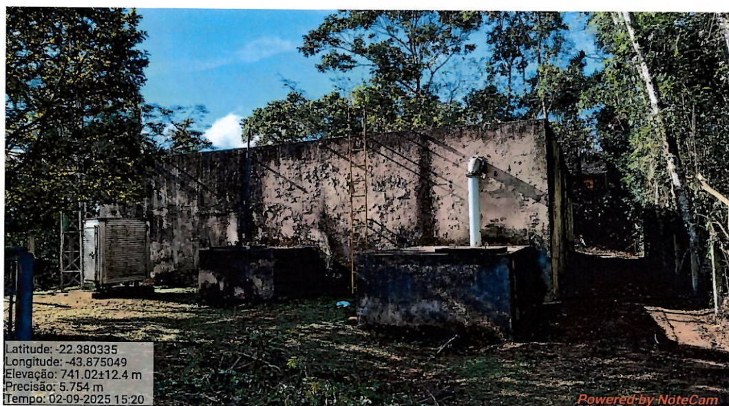
Foto 18: Vista do reservatório.
