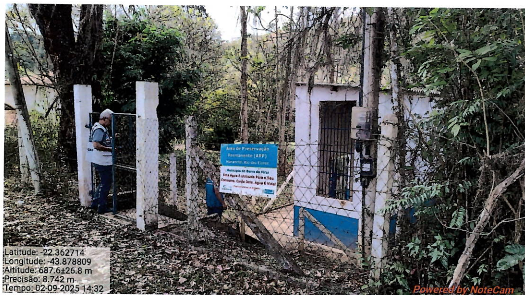
Foto 1: Entrada para o ponto de captação e EEAB (área cercada com placa de identificação de manacial com indicação de uso para consumo humano).
