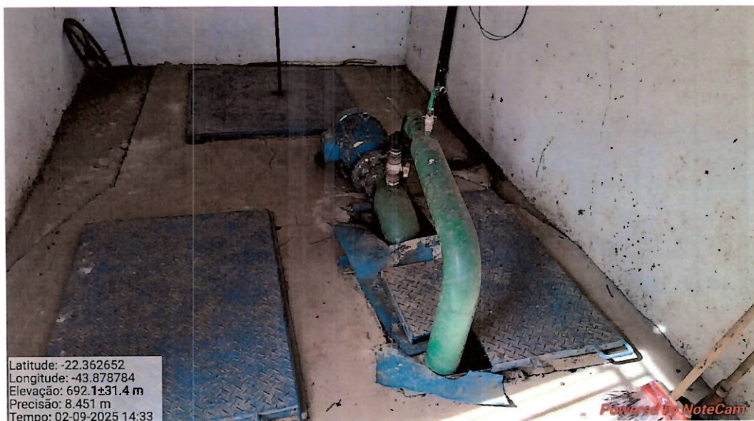
Foto 3: Motobomba em operação.
