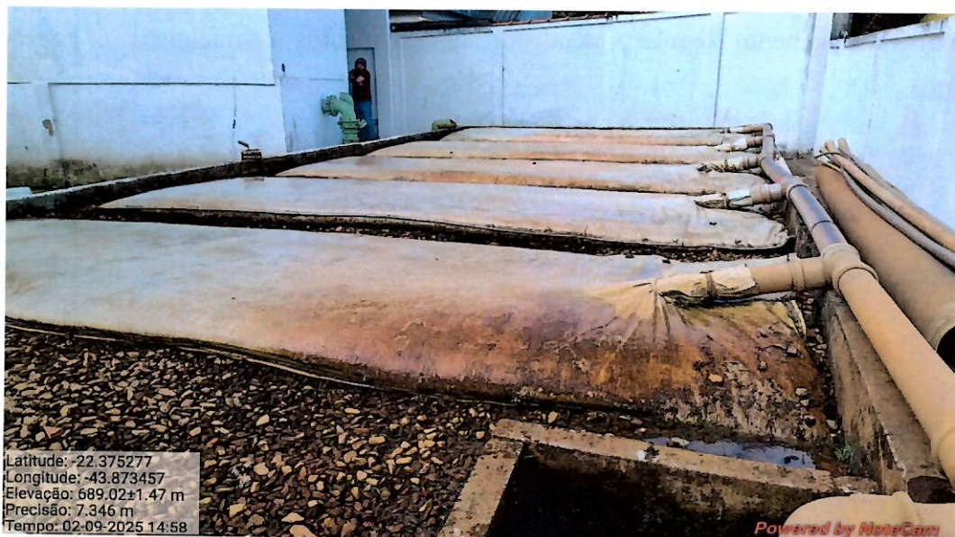
Foto 11: Geobags utilizados no tratamento do lodo.
