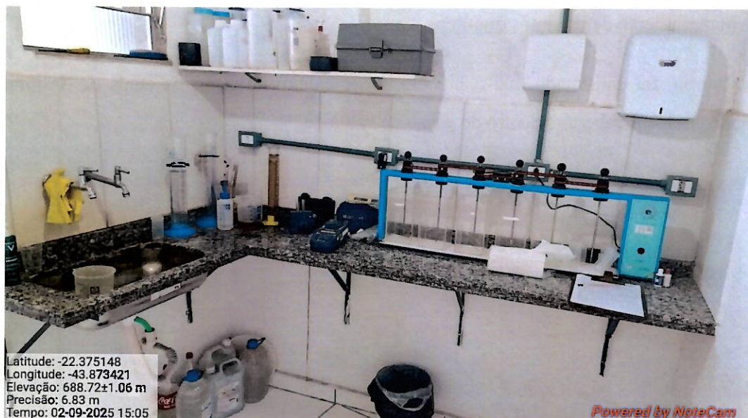
Foto 14: Laboratório da ETA.
