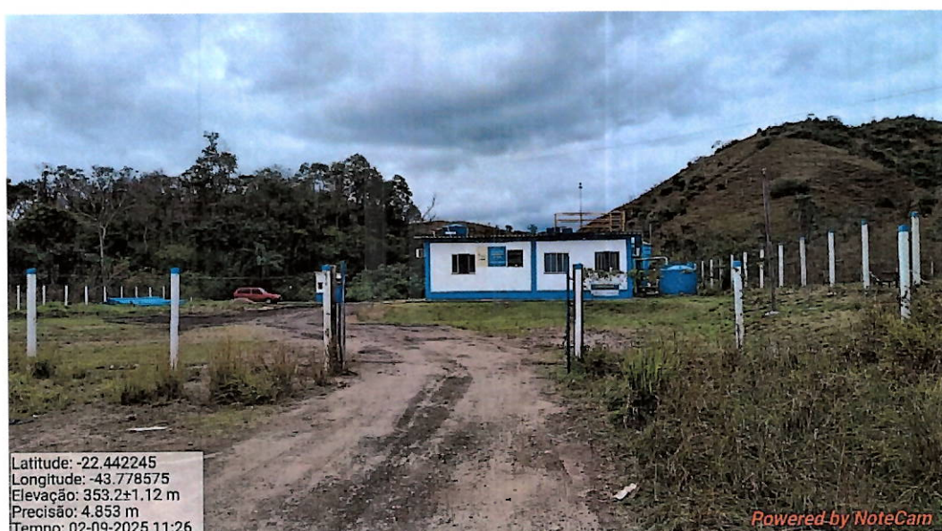
Foto 3: Entrada da ETA (área cercada).
