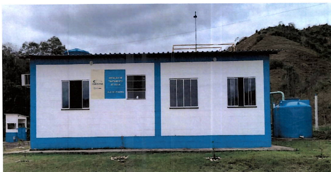
Foto 4: Placa de identificação da ETA.
