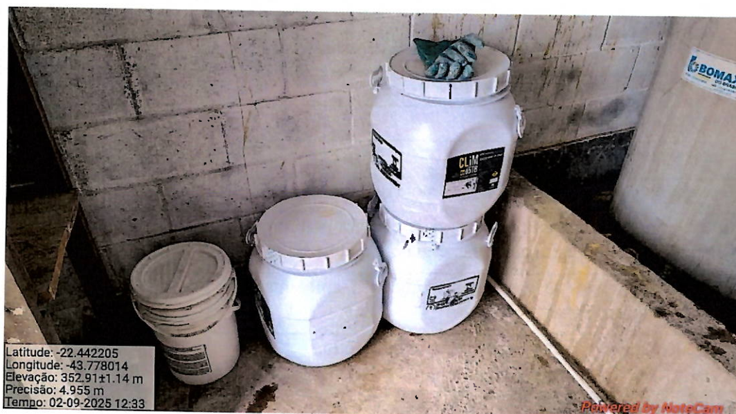
Foto 16: Armazenamento de hipoclorito de cálcio.
