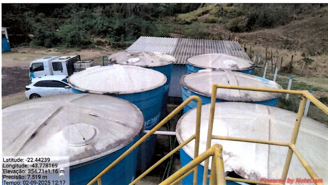
Foto 10: Tanques de capacidade de armazenamento de 20.000 L (um utilizado para cloração e os outros cinco para armazenamento de água tratada).
