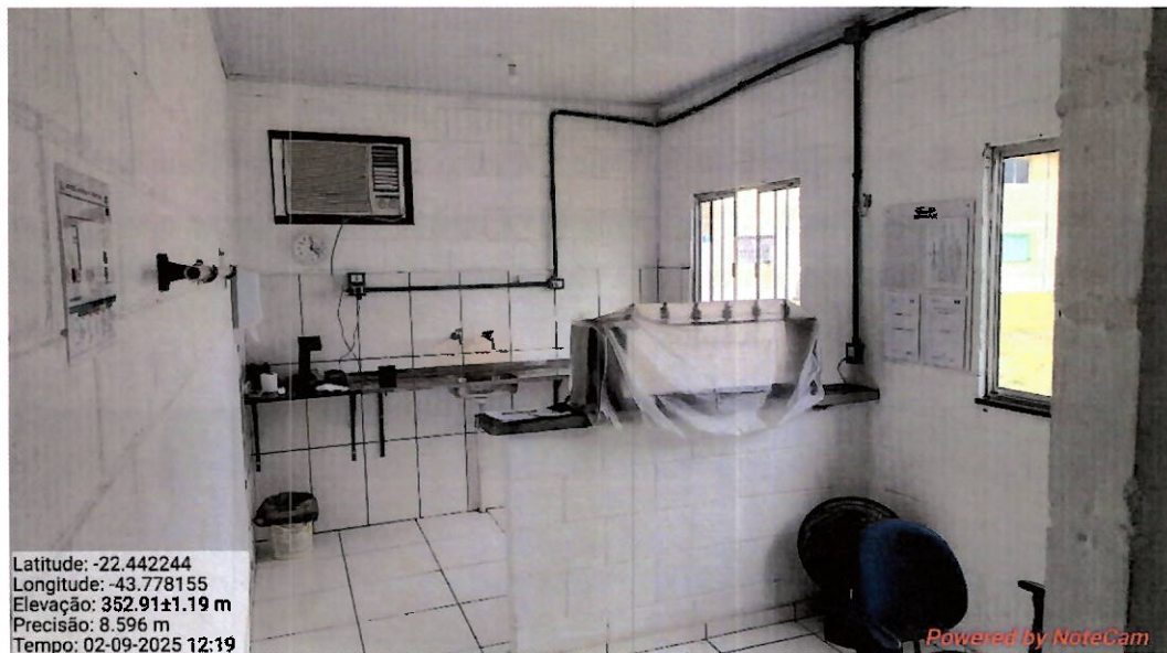
Foto 13: Laboratório da ETA.
