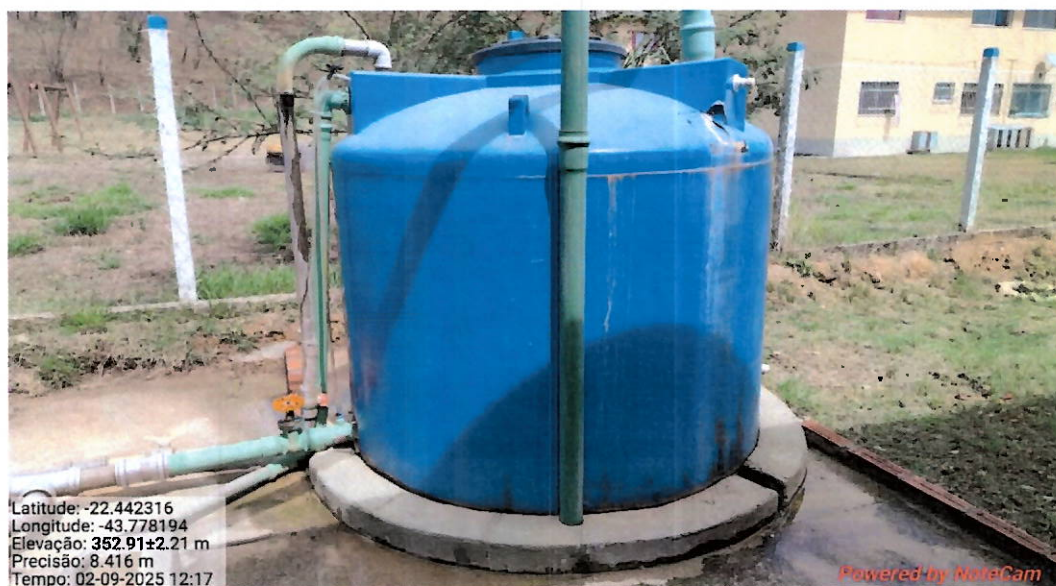
Foto 11: Tanque de armazenamento de ortopolifosfato de sódio (capacidade: 5.000 L).
