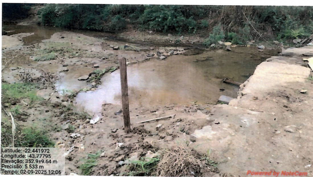
Foto 2: Cerca removida pelo aumento do nível do rio.
