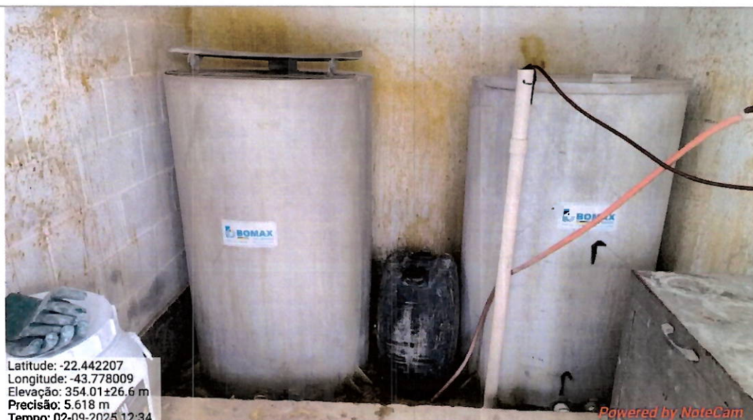
Foto 17: Armazenamento de sulfato de alumínio.
