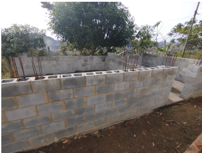
Foto 25 execução de obras para tratamento de Lodo.
