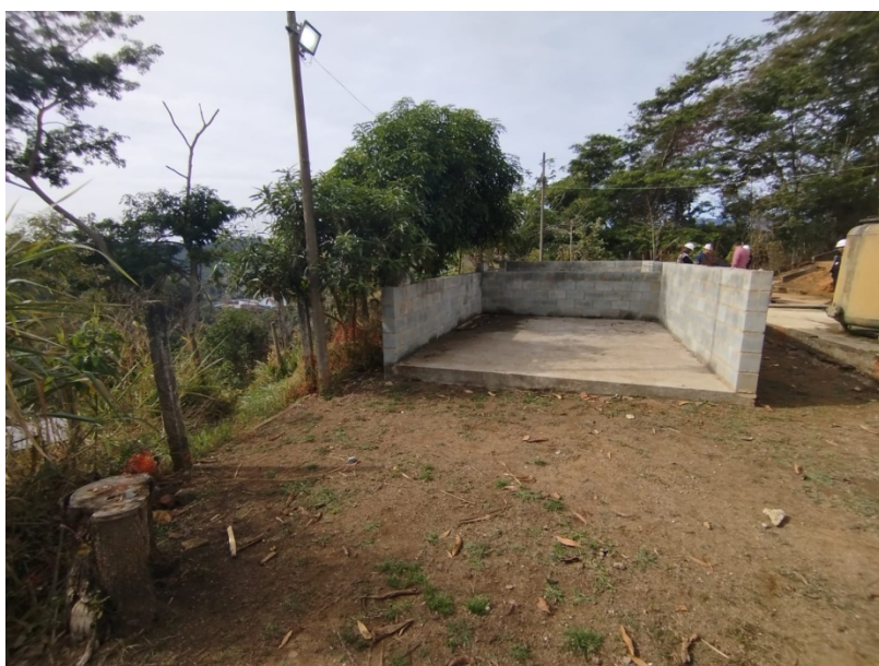
Foto 26 Obras para Tratamento de Lodo.
