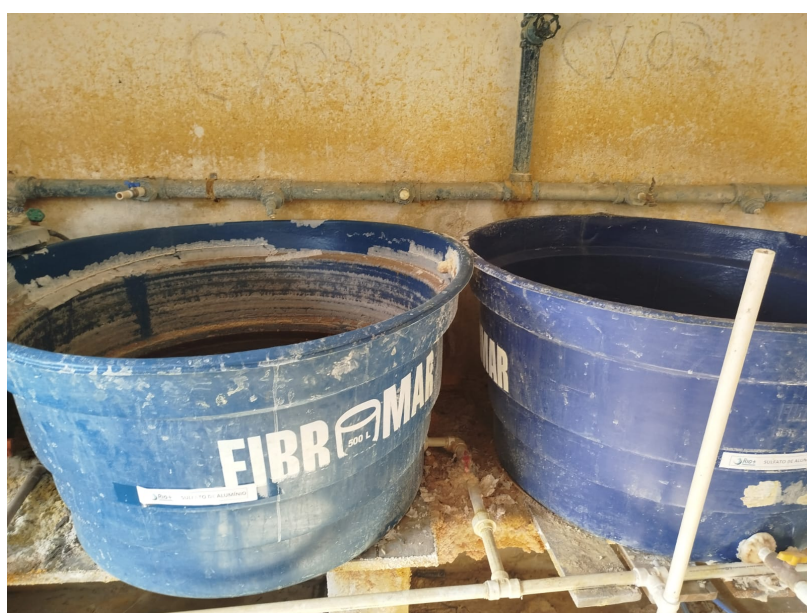
Foto15 Falta de Dique de Contenção.
