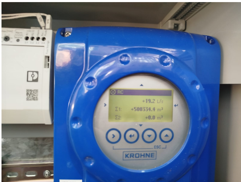
Foto 22 Macromedidor na rede de distribuição.
