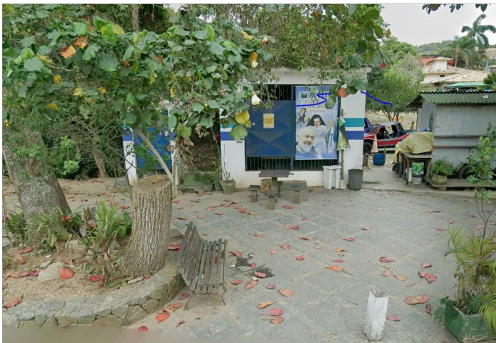
Foto 2 – Vista do abrigo da EEE dos Ossos
