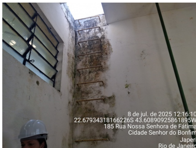
Foto 9 –Escada de acesso a laje
