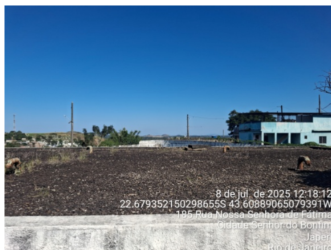
Foto 10 – Laje do reservatório
