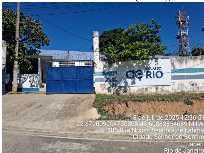
Foto 1 – Fachada área reservatório
