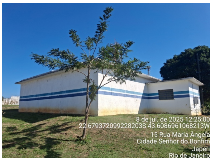
Foto 4 – Resrvatório e abrigo barrilete
