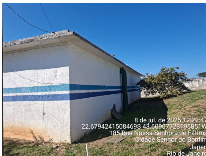
Foto 8 – Tubulação de chegada
