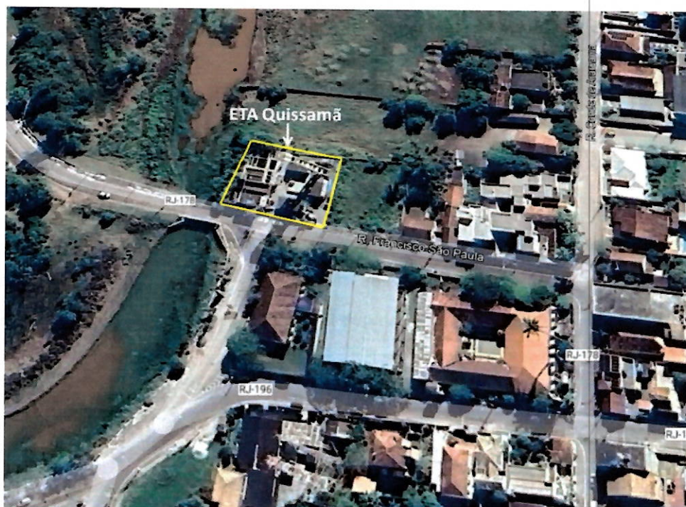
Imagem 1: Localização da ETA Quissamã (22° 6'16.00"S 41°28'21.06"O).
