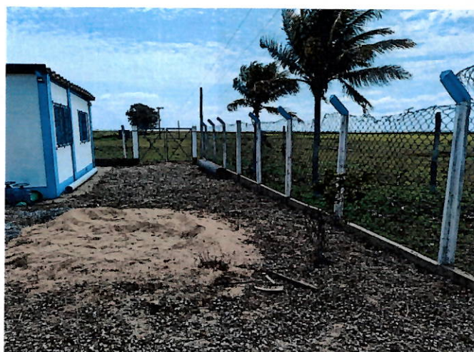
Foto 1: Entrada unidade de captação. Área devidamente cercada.
