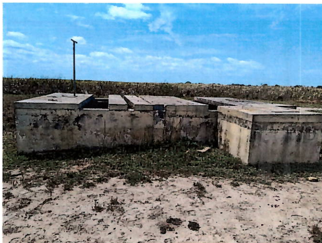
Foto 3: Poço de recalque 1 .
