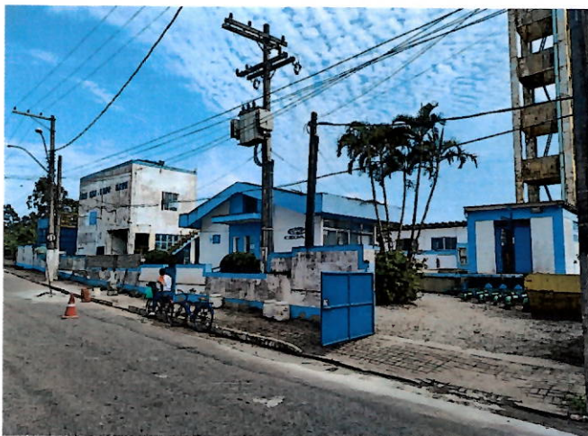
Foto 14: Entrada da ETA Quissamã.
