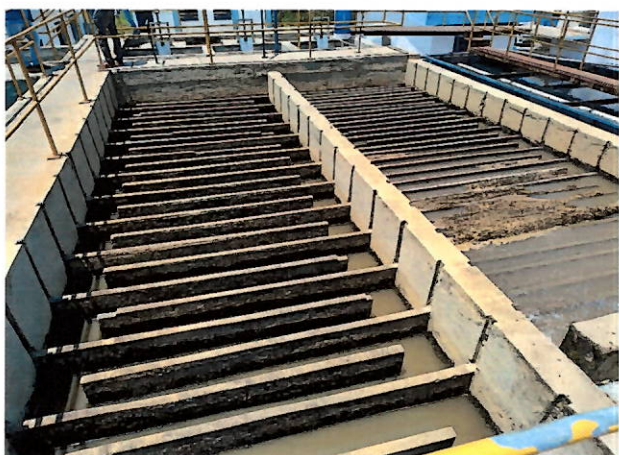
Foto 22: Floculadores da VETA (hidráulico).
