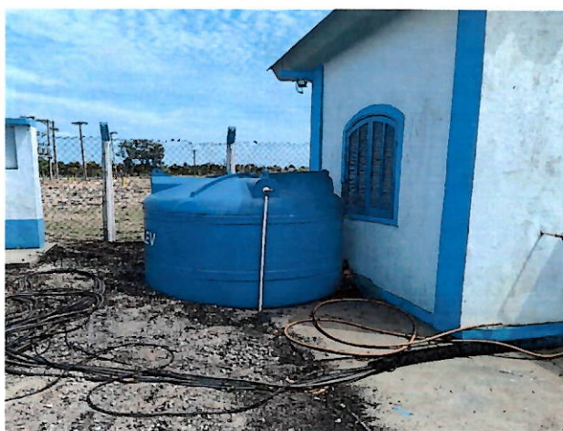
Foto 13: Tanque de diluição de carvão ativado.
