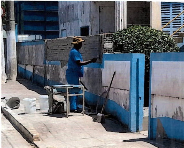
Foto 16: Obra para aumento da altura do muro (frente).
