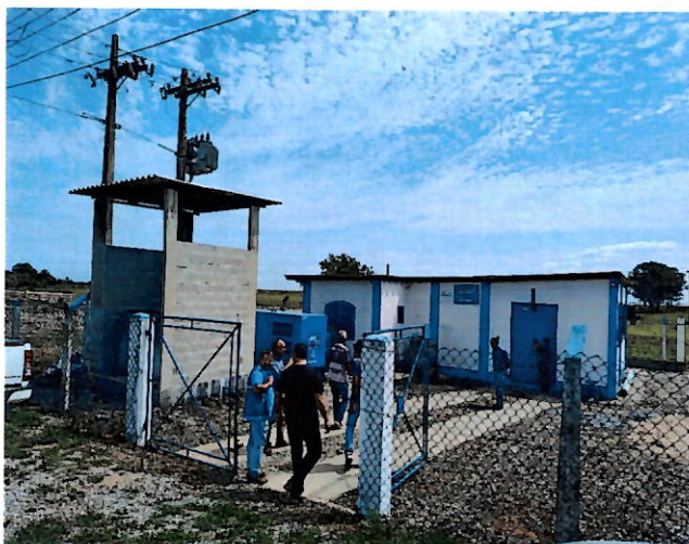
Foto 6: Estação elevatória de água bruta.
