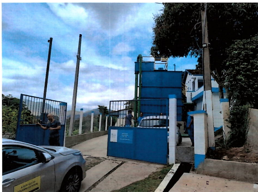
Foto 1 – Vista da ETA com o prédio da administração; o primeiro módulo com calha Parshall, floculador e decantador; Portão, placa de identificação e cerca ao redor.
