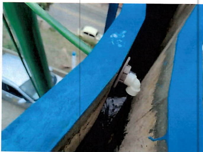
Fotos 5 e 6 – Entrada da água bruta na calha Parshall e dosagem de sulfato de alumínio da ETA.
