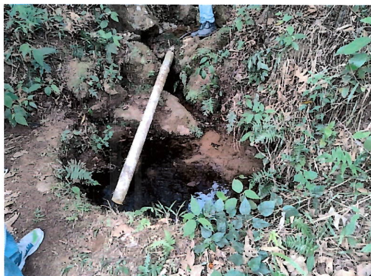
Foto 3 – Captação (baixa vazão: 1,0 l/s )
