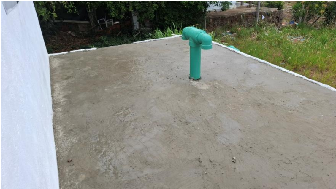
Foto 04 – parte da laje superior e respiro
