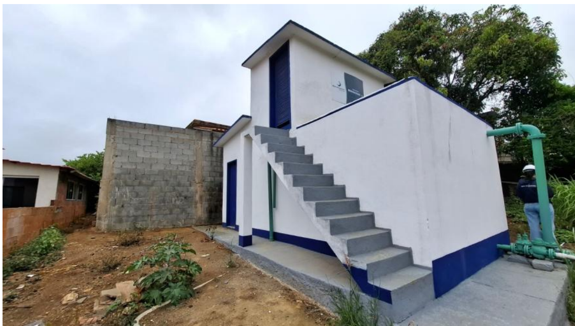
Foto 01 – estrutura do reservatório
