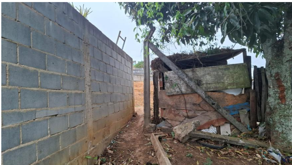
Foto 05 – ponto com abertura do cercamento
