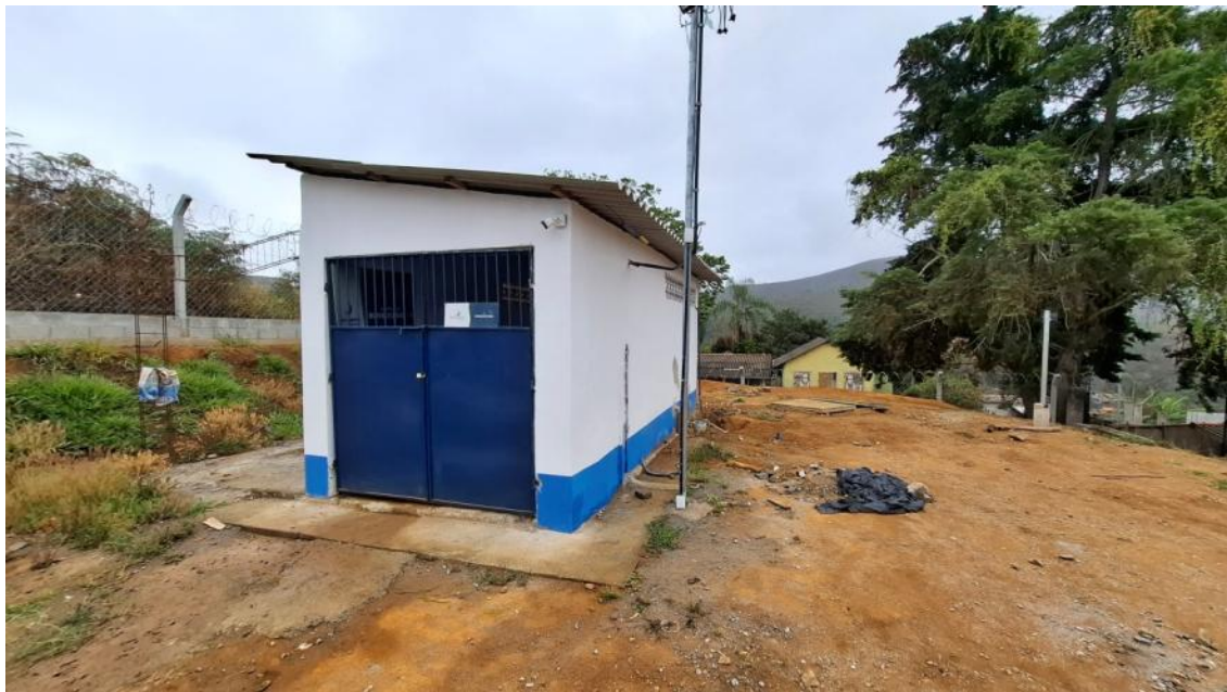
Foto 01 – estrutura da ETA
