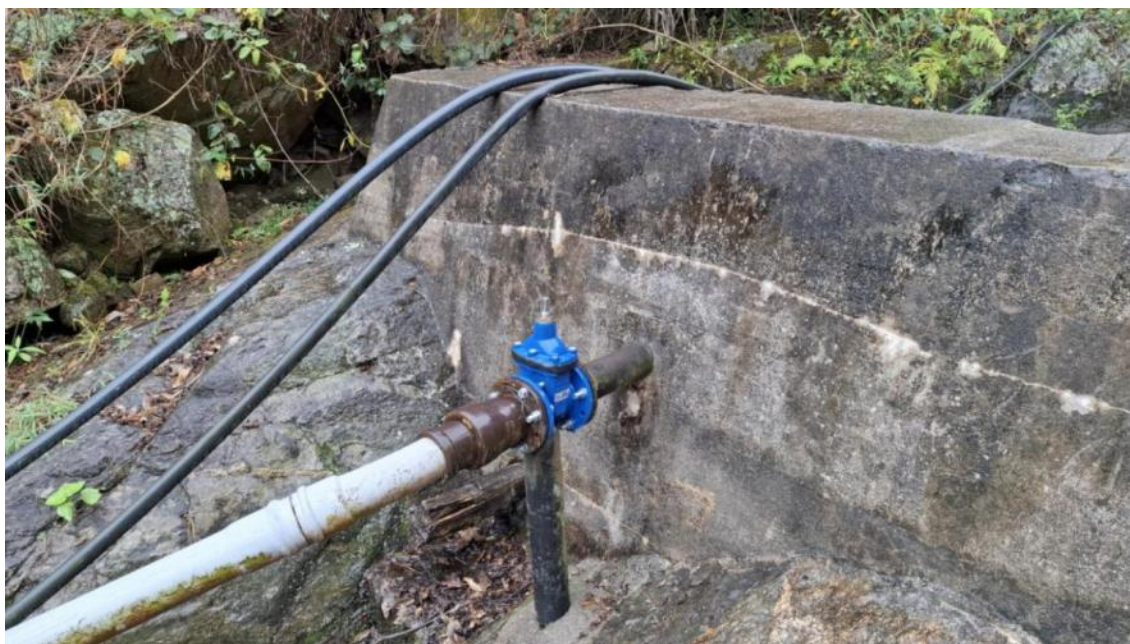
Foto 02 - saída e direcionamento para ETA
