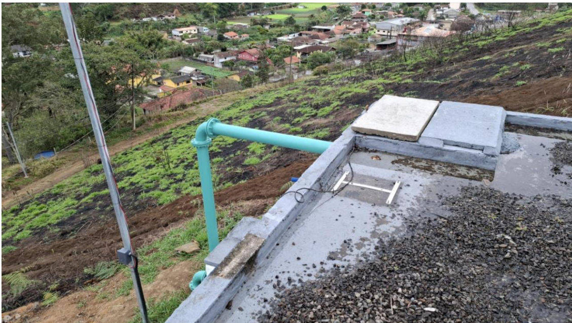
Foto 03 - tubulação de recalque e parte do terreno para acesso a cobertura
