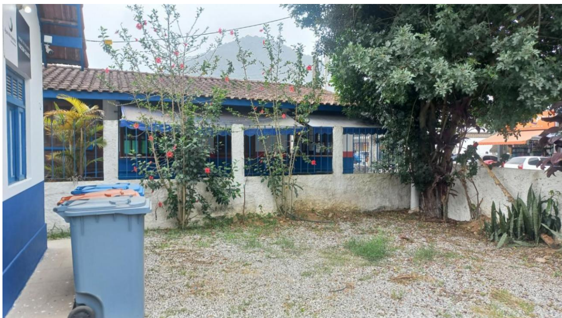
Foto 01 - terreno da ETA
