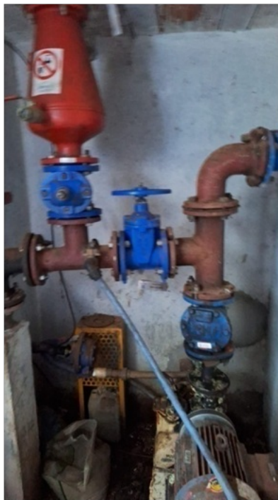
Foto 3 – Montagem eletromecânica da bomba auto-escorvante, que fica de stand-by.
