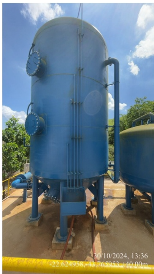
Foto 08 – Floco-decantador e tubulação de análise da qualidade da água floco-decantada
