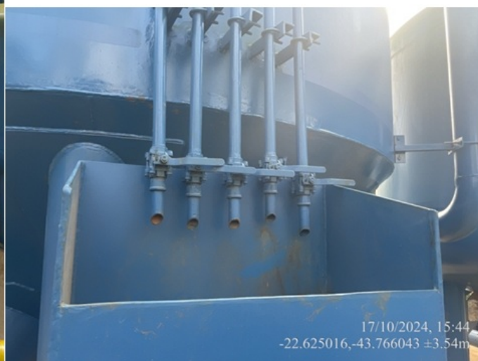
Foto 08 – Floco-decantador e tubulação de análise da qualidade da água floco-decantada
