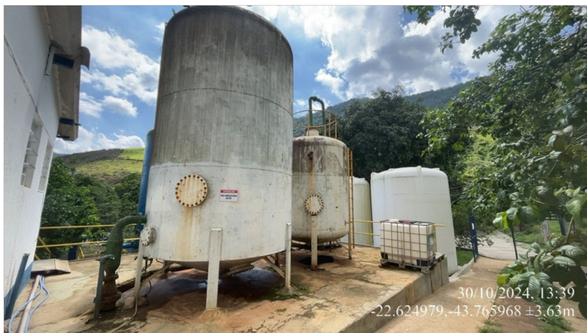
Foto 21 – Espaço desativado da ETA
